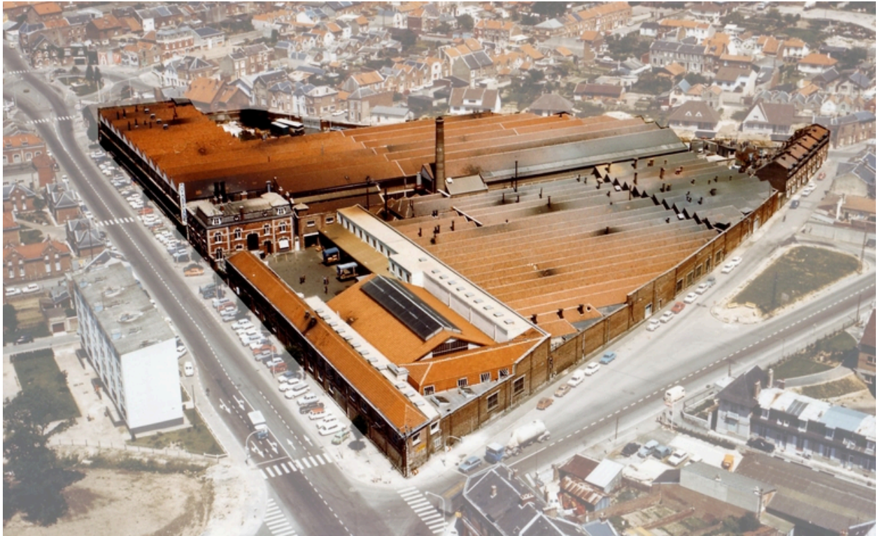
Vue aérienne de l'usine vers 1970 (Société Académique de Saint-Quentin).
