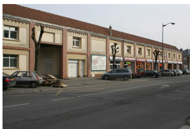
Façade des entrepôts et magasins de 1921, rue de La Fère. Phot. Frédéric Pillet IVR22_20060205113NUCA
