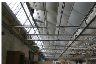
Ateliers de 1921 : détail d'un shed.
