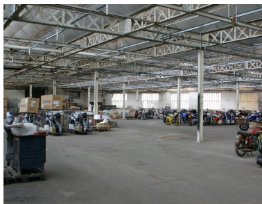
Vue intérieure des ateliers de 1921.
