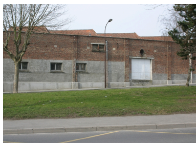
Façade des ateliers de 1921, rue Ribaudois. Phot. Frédéric Pillet IVR22_20060205112NUCA
