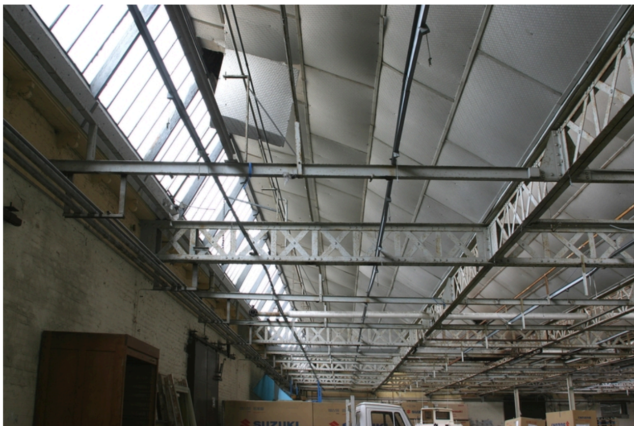
Ateliers de 1921 : détail d'un shed.
