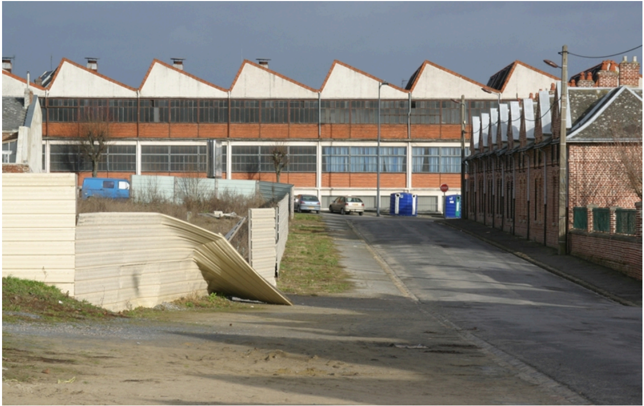
Ateliers de 1954 (à droite, le béguinage des Vieux Ménages).
