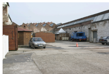
Au premier plan, l'emplacement où s'élevaient la salle des machines, la chaufferie, etc. A l'arrière-plan, les ateliers reconstruits en 1921. Phot. Frédéric Pillet
