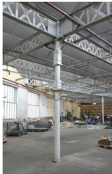
Vue intérieure des ateliers de 1921 : détail d'une colonne de fonte.
