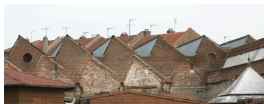
Détail des sheds des ateliers de 1921.
