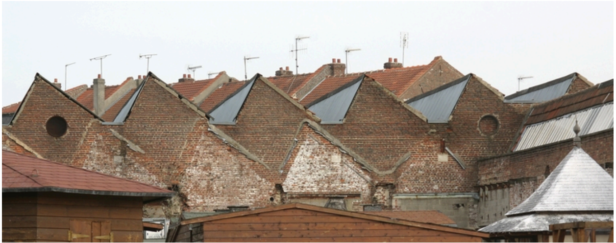
Détail des sheds des ateliers de 1921.
