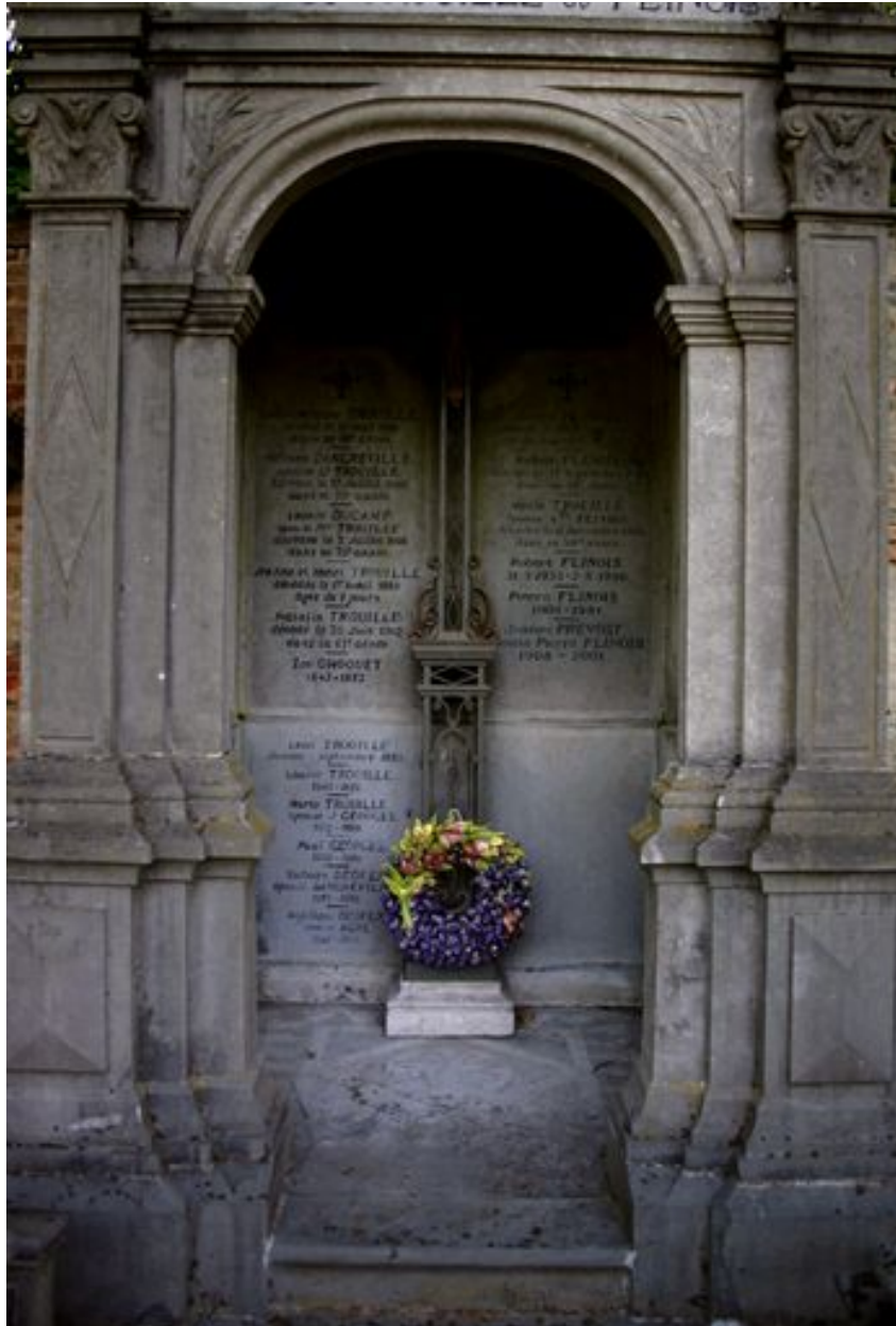
Decor sculpté des pilastres ornant l'entrée du tombeau-chapelle.
