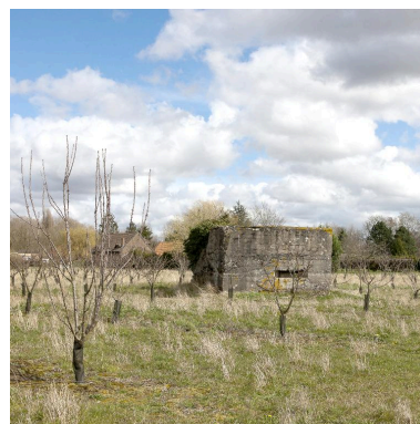
Vue vers le sud-ouest Phot. Jean-Marc Ramette IVR31_20145904277NUCA
