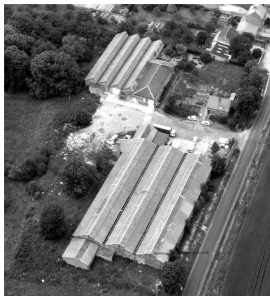
Vue aérienne, flanc est. Phot. Phot'R IVR22_19908011675P
