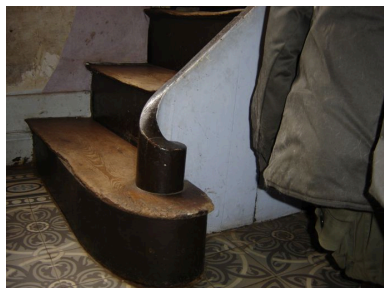
Vue du bas de l'escalier. Phot. Inès Guérin IVR22_20058006142NUCA
