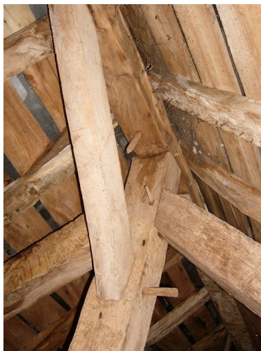
Détail de la charpente. Phot. Inès Guérin IVR22_20058006141NUCA
