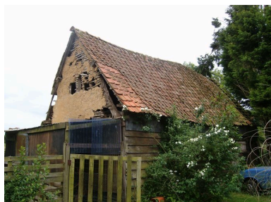
Vue latérale des écuries. Phot. Inès Guérin IVR22_20058006149NUCA
