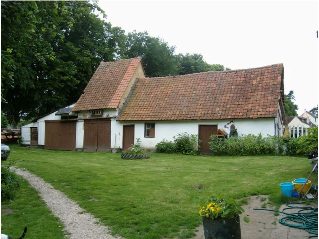
Vue du pigeonnier et des anciens logements pour ouvriers.
