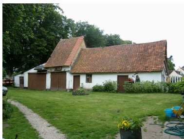
Vue du pigeonnier et des anciens logements pour ouvriers. Phot. Inès Guérin IVR22_20058006151NUCA
