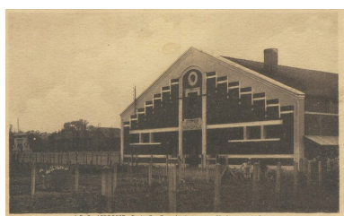
Vue de la façade d'entrée de la piscine municipale de Leforest, carte postale, vers 1940 (coll. part.). Phot. Laurence Schlosser (reproduction) IVR32_20176205058NUCA
