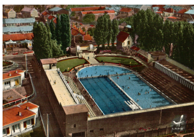
Vue aérienne de la piscine municipale de Bruay-en-Artois (actuelle Bruay-la-Buissière). Phot. Laurence Schlosser (reproduction) IVR32_20176205062NUCA
