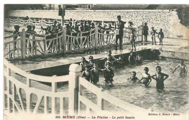
Vue du petit bassin de la piscine de Méru, carte postale, vers 1935 (coll. part.). Phot. Laurence Schlosser (reproduction) IVR32_20176005120NUCA
