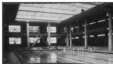
Vue intérieure de la piscine pasteur de Maubeuge avant un cours de natation. Dans le fond, noter le plongeur et les vitraux représentant des scènes marines. Photographie, vers 1940 (AC Maubeuge). Phot. Laurence Schlosser (reproduction) IVR32_20175905048NUCA
