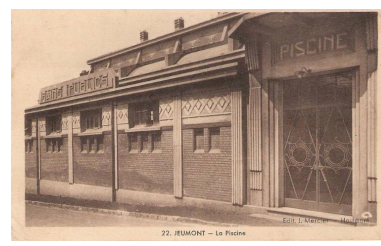
Jeumont (Nord), façade d'entrée de la piscine construite en 1927 par Adolphe Danis, carte postale, vers 1930 (coll. part.). Phot. Laurence Schlosser (reproduction) IVR32_20175905067NUCA
