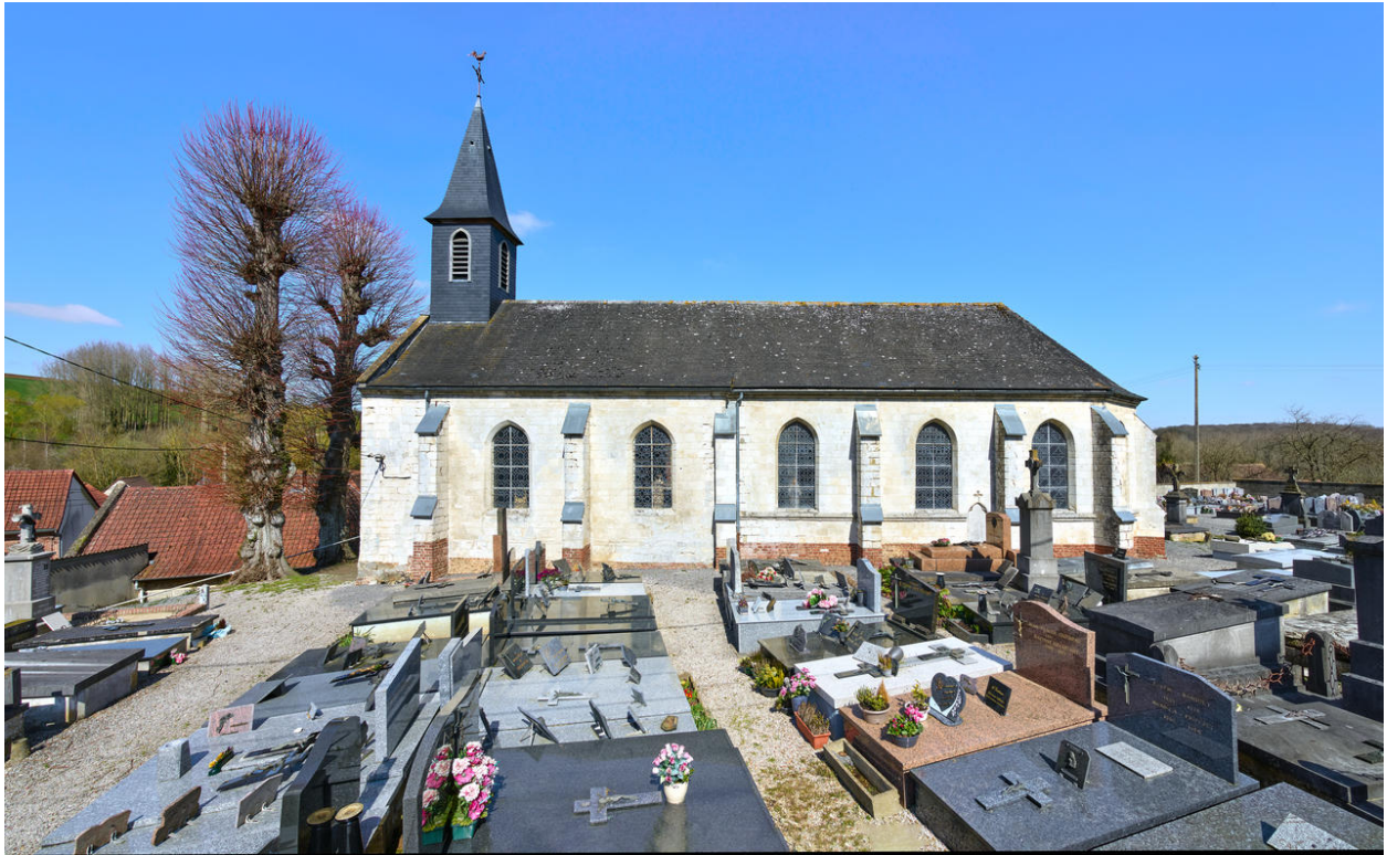
Vue de l'élévation sud.
