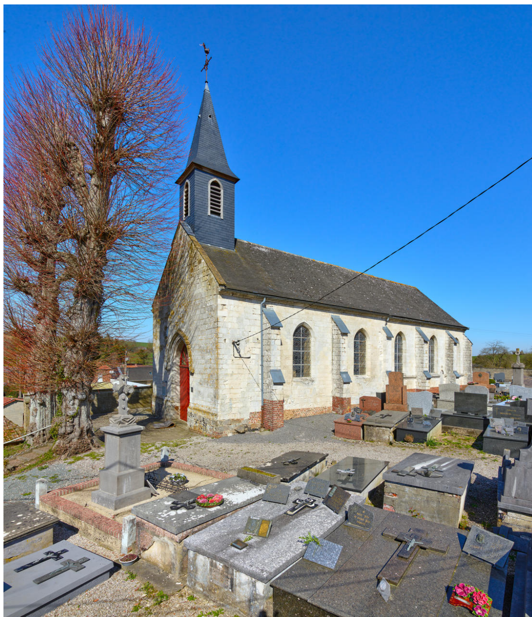
Vue depuis le sud-ouest.
