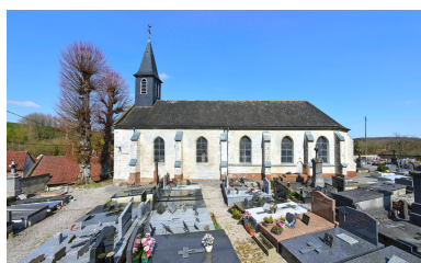
Vue de l'élévation sud. Phot. Thierry Lefébure IVR32_20236200356NUCA
