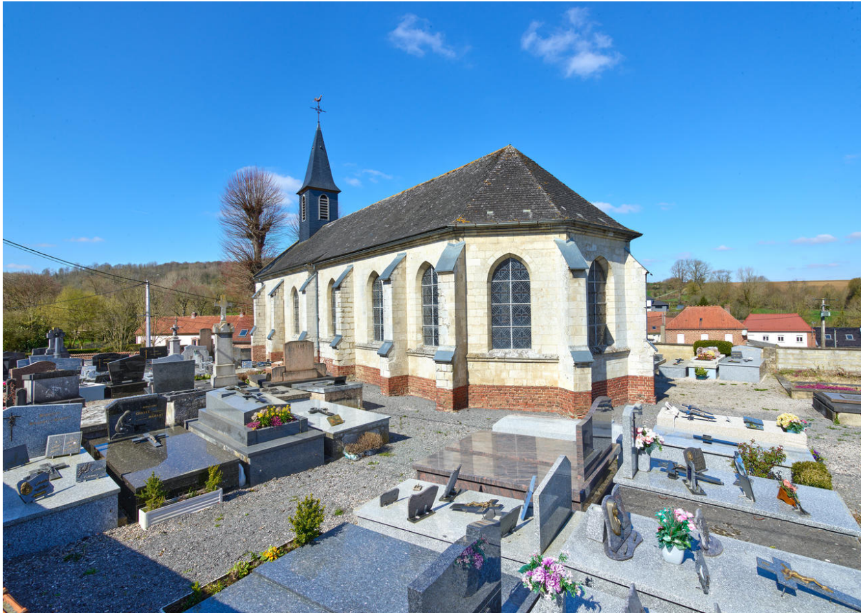
Vue du chevet depuis le sud-est.
