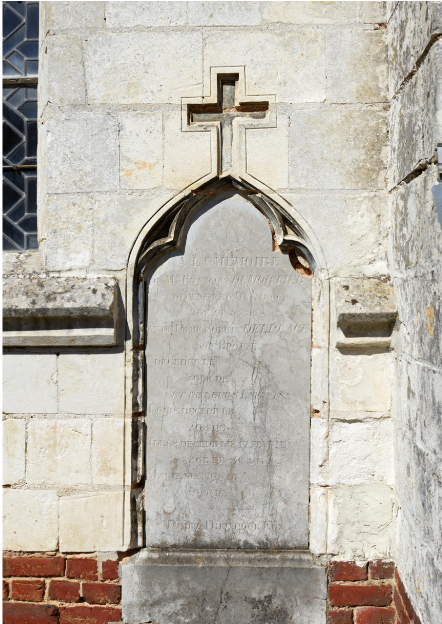
Plaque funéraire sur l'élévation sud de l'église.
