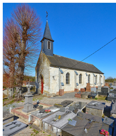
Vue depuis le sud-ouest.
