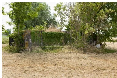
Vue générale, vers le sud-ouest Phot. Jean-Marc Ramette IVR31_20145905175NUCA
