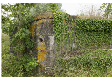
Angle sud-ouest. Sortie d'ération, échelons métalliques et main courante Phot. Jean-Marc Ramette IVR31_20145905186NUCA
