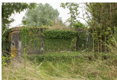
Vue vers l'ouest. Poste du mitrailleur et des servant. On remarque des échelons et une main courante, à gauche Phot. Jean-Marc Ramette IVR31_20145905188NUCA
