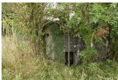
Ouverture sur pan coupé nord. Sortie d'aération et échelons métalliques permettant l'accès au couvrement Phot. Jean-Marc Ramette IVR31_20145905174NUCA
