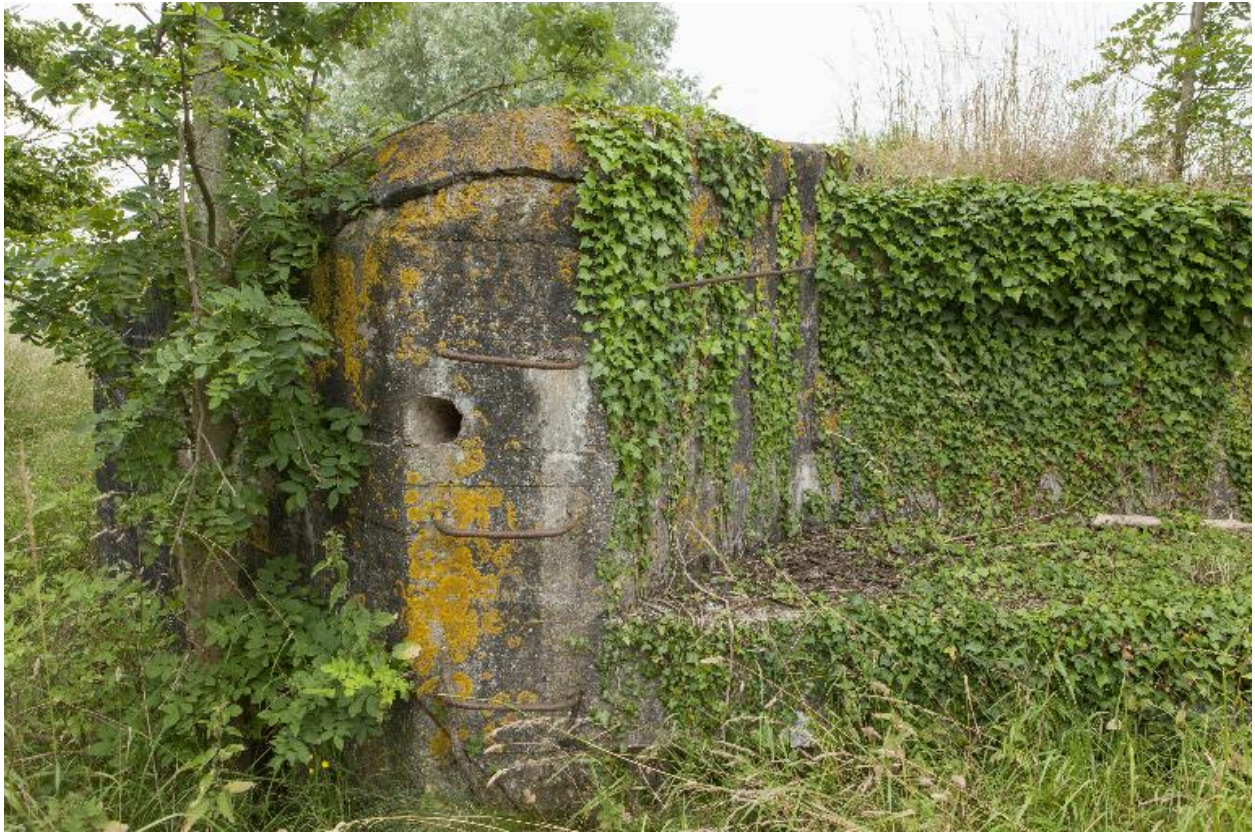
Angle sud-ouest. Sortie d'ération, échelons métalliques et main courante
