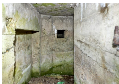
Couloir en chicane avec créneau de fusillade depuis l'entrée sud Phot. Jean-Marc Ramette IVR31_20145905183NUCA
