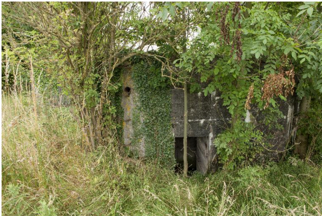
Ouverture sur pan coupé nord. Sortie d'aération et échelons métalliques permettant l'accès au couvrement
