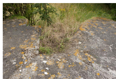
Cuve trapézoïdale de la mitrailleuse sur le couvrement. A gauche le logement du servant alimentant la machine Phot. Jean-Marc Ramette IVR31_20145905189NUCA
