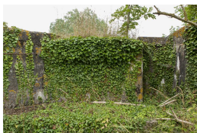
Poste de tir. Le mitrailleur était au centre, un servant à sa droite alimentait la mitrailleuse. Un troisième à sa gauche dirigeait le tir Phot. Jean-Marc Ramette IVR31_20145905187NUCA
