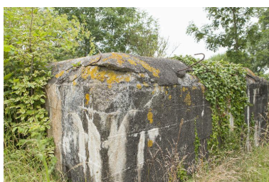
Angle nord-ouest. Crochets de fixation de la toile de camouflage Phot. Jean-Marc Ramette IVR31_20145905191NUCA
