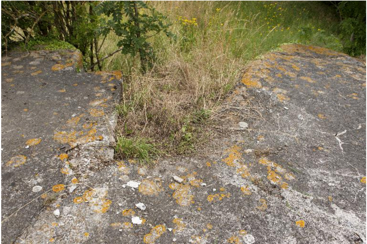
Cuve trapézoïdale de la mitrailleuse sur le couverture. A gauche le logement du servant alimentant la machine
