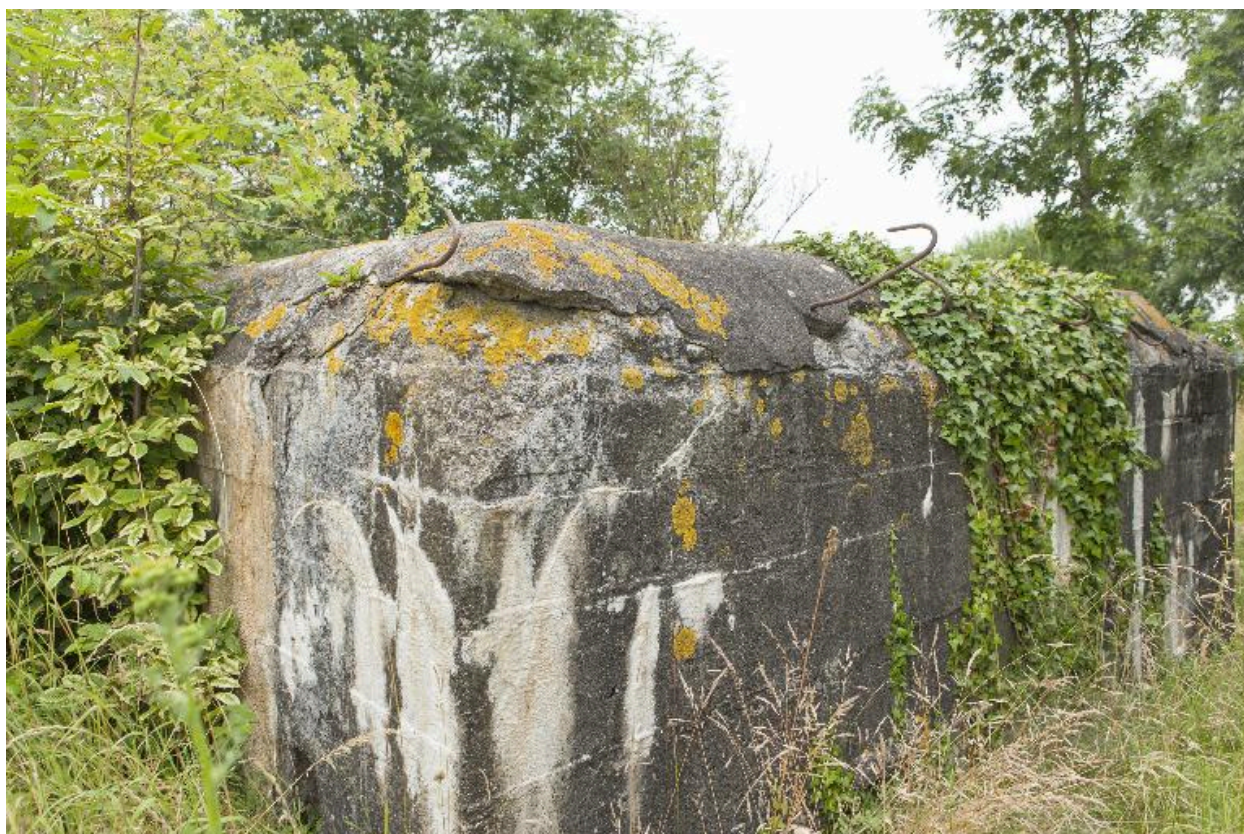
Angle nord-ouest. Crochets de fixation de la toile de camouflage
