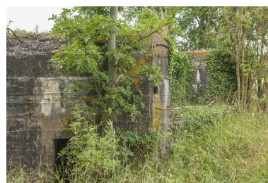
Entrée sur le pan coupé sud Phot. Jean-Marc Ramette IVR31_20145905192NUCA
