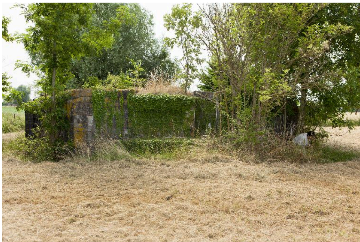
Vue générale, vers le sud-ouest
