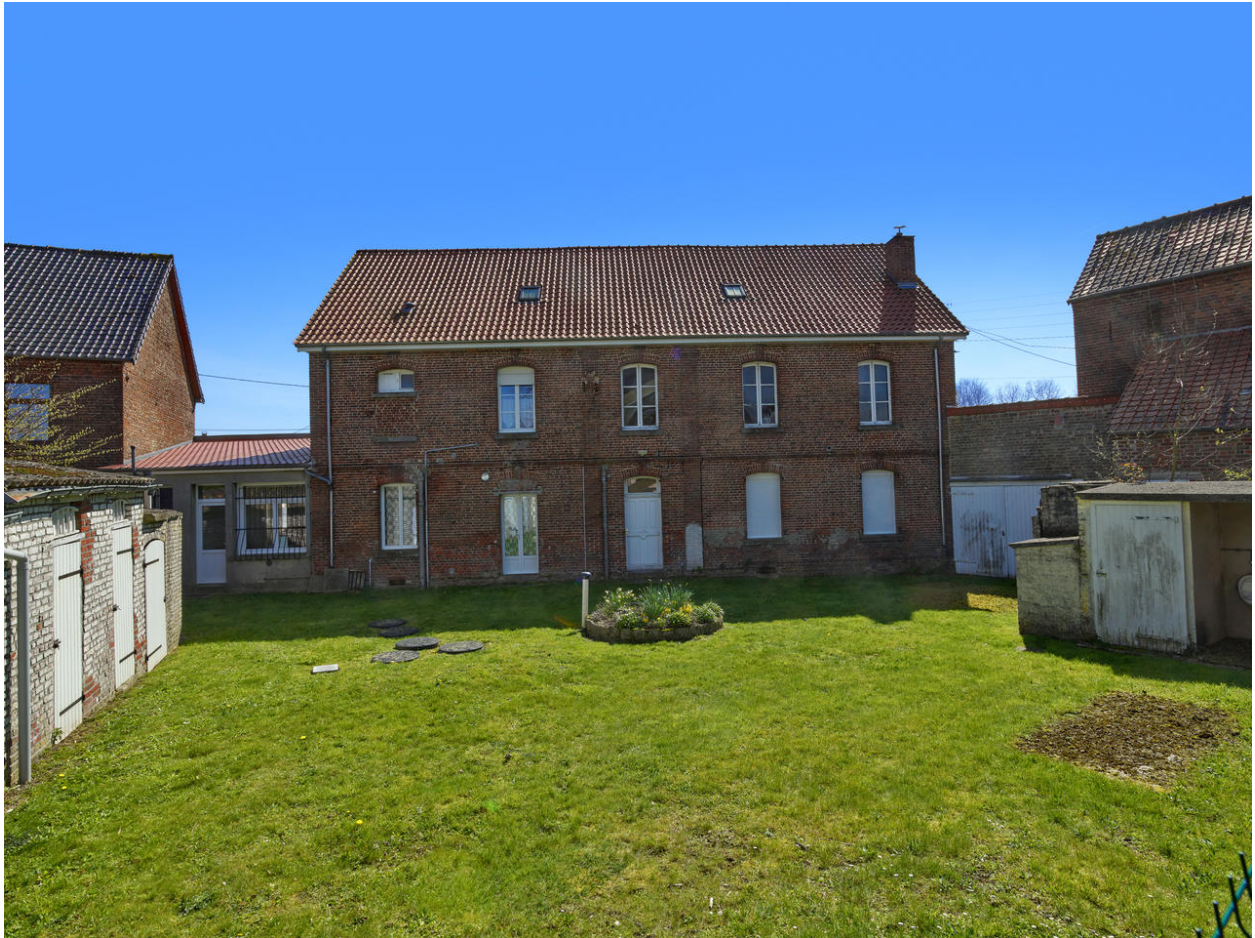
Vue de l'élévation postérieure au nord.
