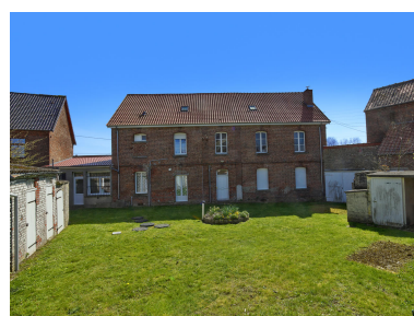
Vue de l'élévation postérieure au nord. Phot. Thierry Lefébure IVR32_20236200320NUCA
