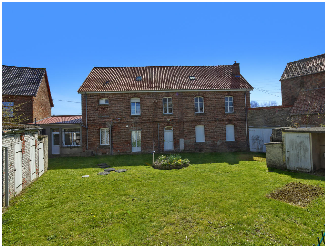
Vue de l'élévation postérieure au nord.
