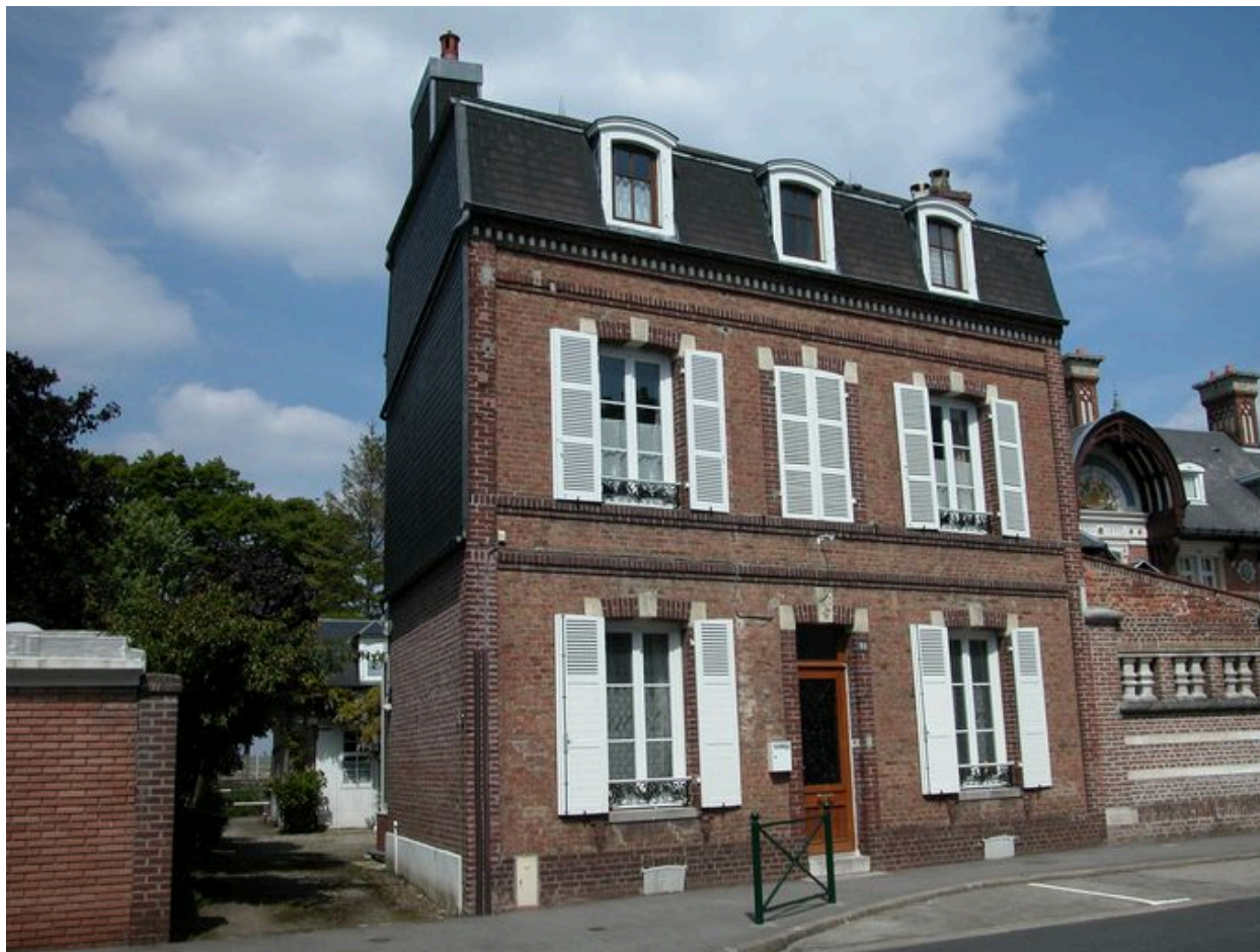
Vue d'ensemble depuis le quai du Romerel.
