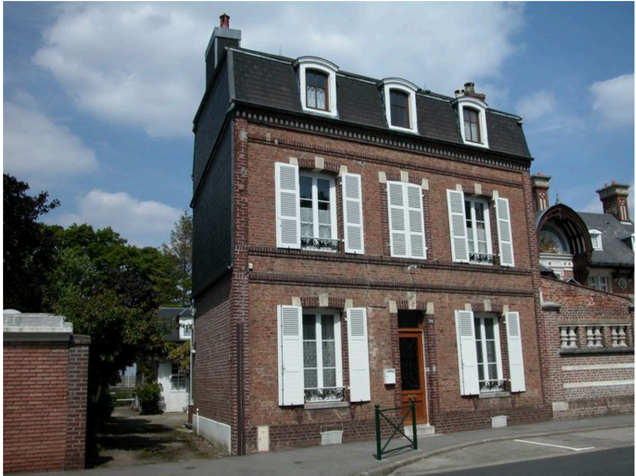
Vue d'ensemble depuis le quai du Romerel.
