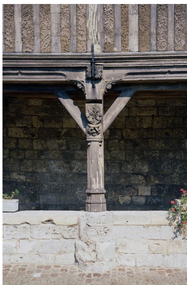
Détail de la structure. Phot. Fabrice Charrondière IVR22_19856001282XA
