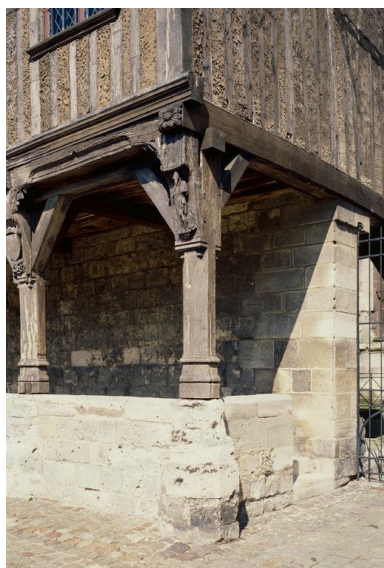
Détail de la structure. Phot. Fabrice Charrondière IVR22_19856001272XA
