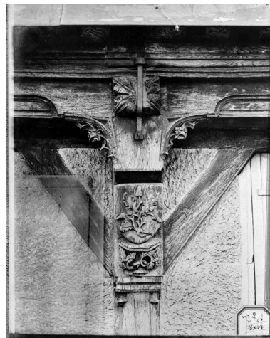
Détail poteau et sablière, avant 1914 (BM Compiègne). Phot. Jean-Michel Périn IVR22_19846000202XB
