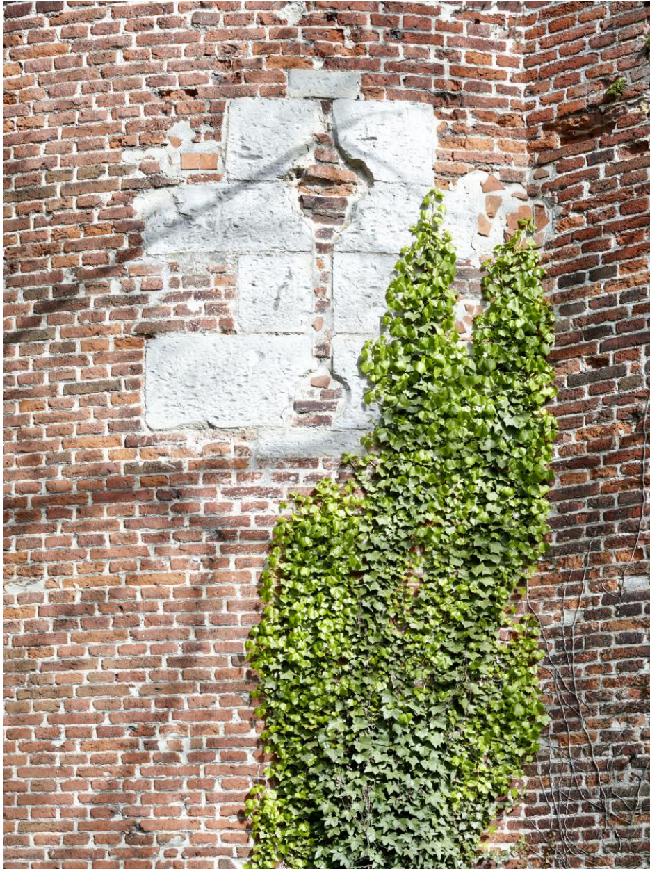
Vue extérieure. Détail de l'ouverture de tir comblée située au niveau principal (R+1). Niche nord-ouest avec rayère percée de deux ouvertures de tir circulaires.
