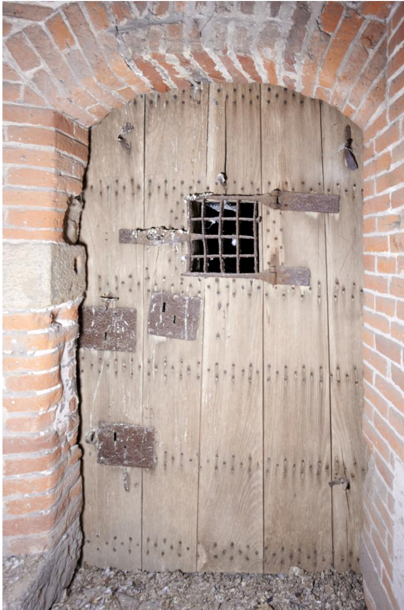
Niveau principal (R+1). Vue de la porte d'accès à la salle depuis la tour d'escalier. Porte à guichet.
