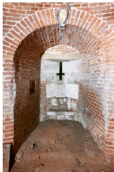
Niveau inférieur. Détail de l'embrasure de tir nord-ouest (en "fente à croix"). Phot. Delphine Volto-Jourdan IVR22_20225900117NUCA
