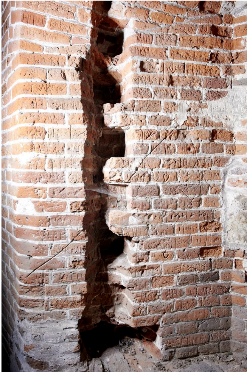
Niveau principal (R+1). Détail de l'intrados de la niche de tir nord-ouest (et modification structurelle indéterminée).
