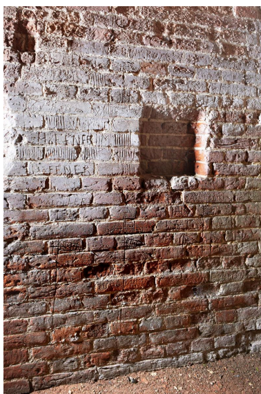
Niveau inférieur. Vue générale de la niche sud-ouest. Gravures réalisées dans la brique. Phot. Delphine Volto-Jourdan IVR22_20225900125NUCA
