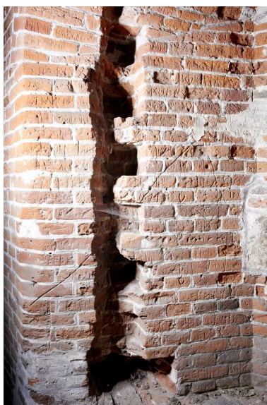
Niveau principal (R+1). Détail de l'intrados de la niche de tir nord-ouest (et modification structurelle indéterminée). Phot. Delphine Volto-Jourdan IVR22_20225900140NUCA
