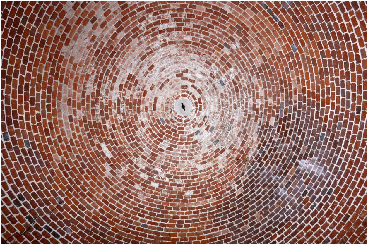
Niveau principal (R+1). Détail de la coupole traitée en plein cintre.
