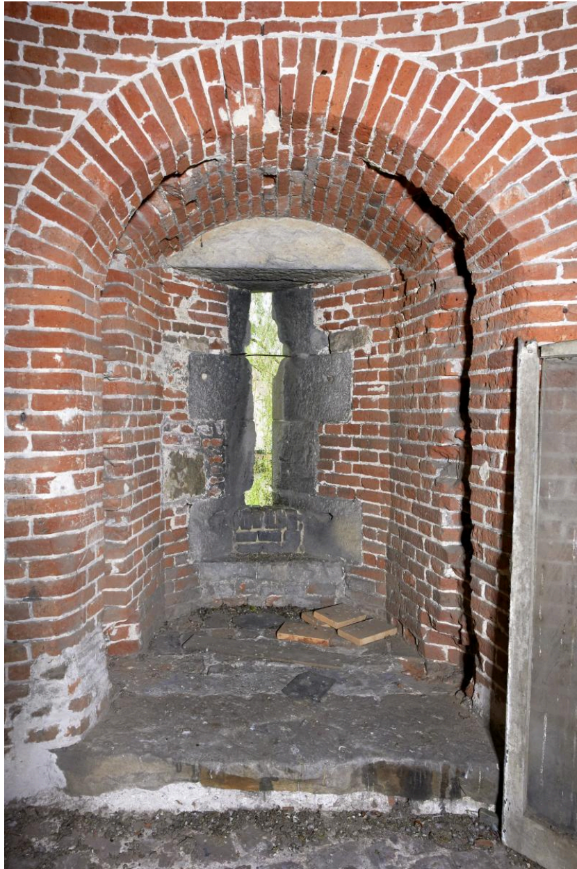
Niveau principal (R+1). Niche de tir nord-ouest.
