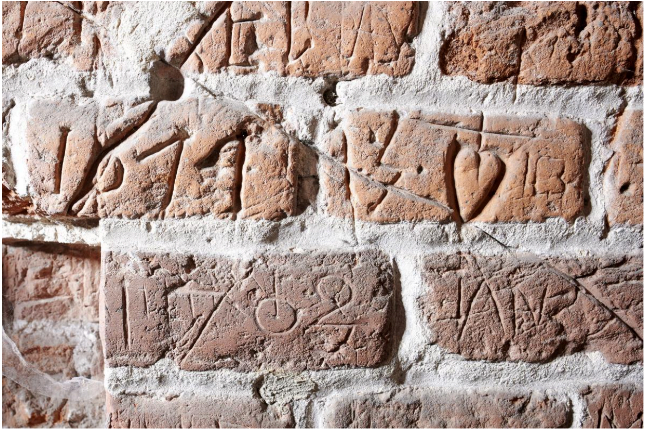
Niveau principal (R+1). Détails des gravures réalisées dans la briques (1611, 1702, Sacré-Coeur).
