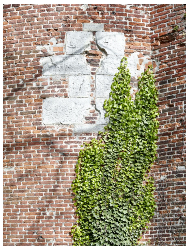
Vue extérieure. Détail de l'ouverture de tir comblée située au niveau principal (R+1). Niche nord-ouest avec rayère percée de deux ouvertures de tir circulaires. Phot. Delphine Volto-Jourdan IVR22_20225900163NUCA
