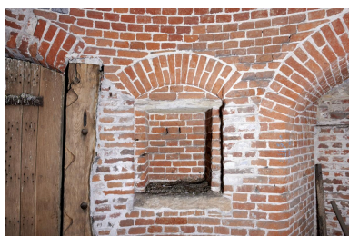
Niveau principal (R+1). Petite niche murale carrée à proximité de la porte d'accès. Phot. Delphine Volto-Jourdan IVR22_20225900134NUCA
