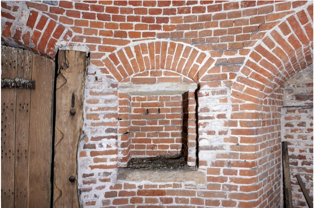
Niveau principal (R+1). Petite niche murale carrée à proximité de la porte d'accès.
