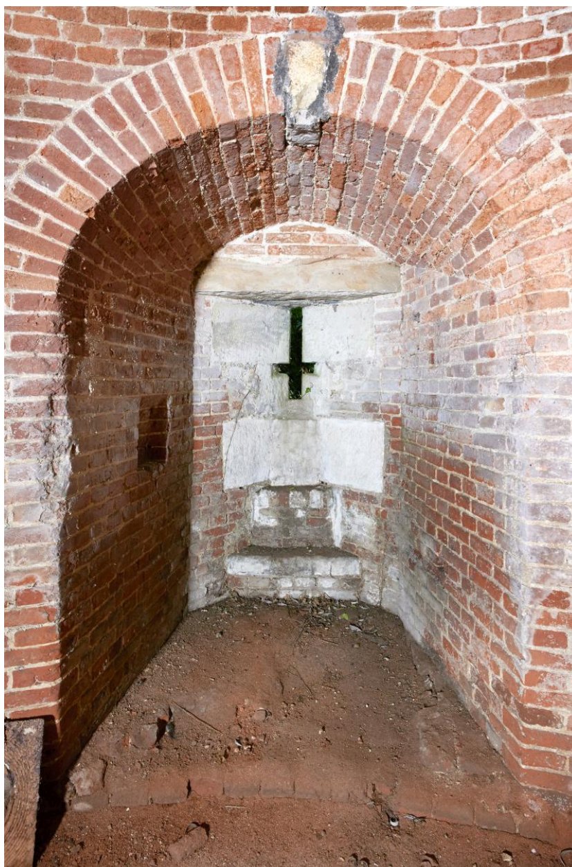
Niveau inférieur. Détail de l'embrasure de tir nord-ouest (en "fente à croix").
