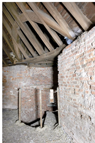
Chemin de ronde. Vue vers la tour d'escalier et la charpente du début 20e s. Phot. Delphine Volto-Jourdan IVR22_20225900151NUCA
