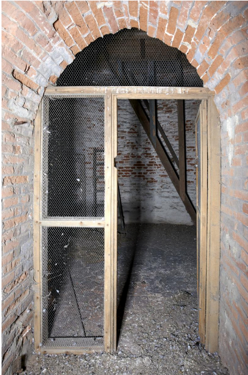
Chemin de ronde. Ouverture en voûte d'ogive donnant accès à la salle circulaire interne.
