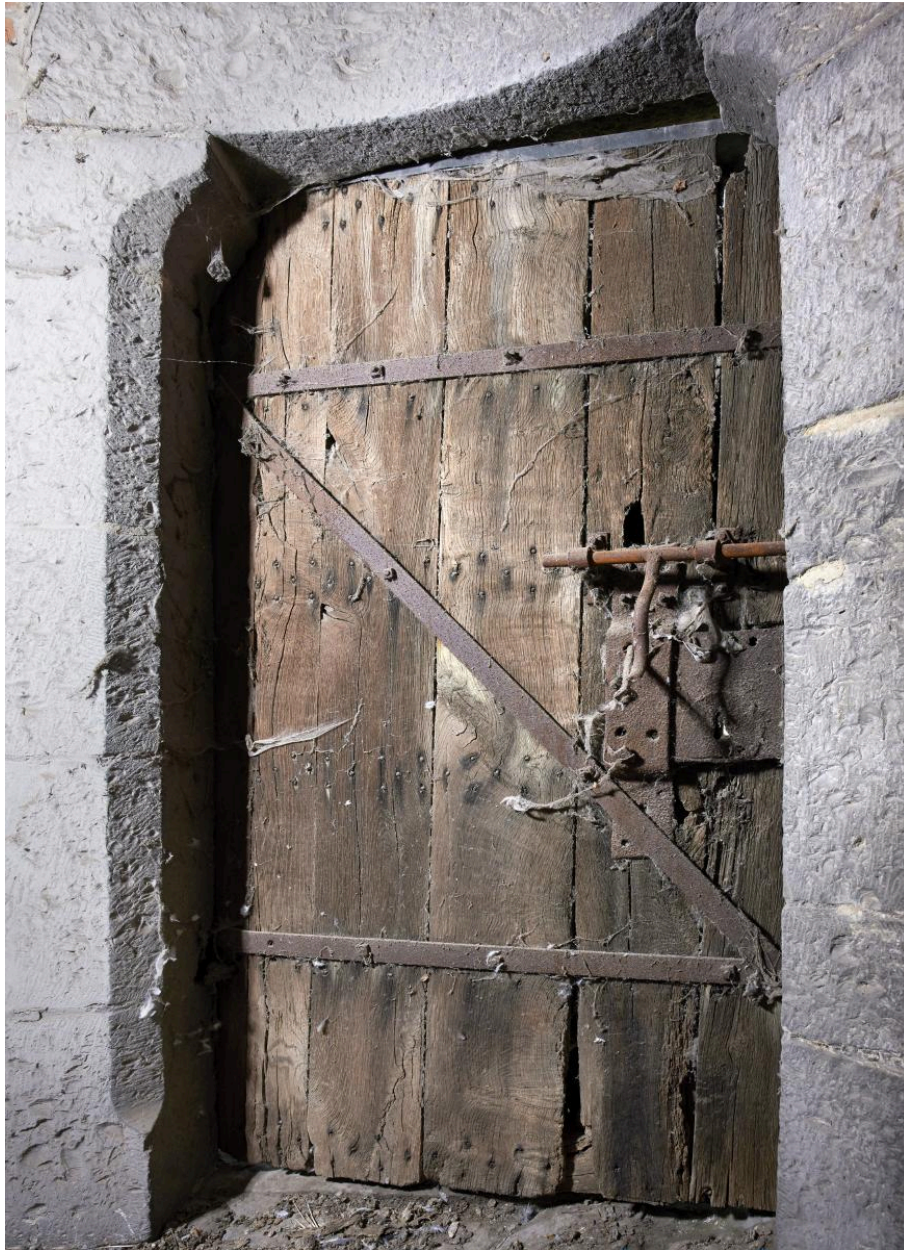
Porte du niveau "intermédiaire" donnant sur l'ancienne courtine. Traitement architectural de l'encadrement en grès.
