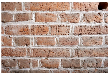
Niveau principal (R+1). Détails des gravures réalisées dans la briques ("LA FLEUR DE METZ 1674", 1637, 1653, "A" traité en compas et équerre). Phot. Delphine Volto-Jourdan IVR22_20225900147NUCA
