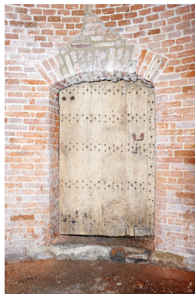
Niveau inférieur. Porte d'accès. Vue intérieure (présence de xylographies). Phot. Delphine Volto-Jourdan IVR22_20225900120NUCA
