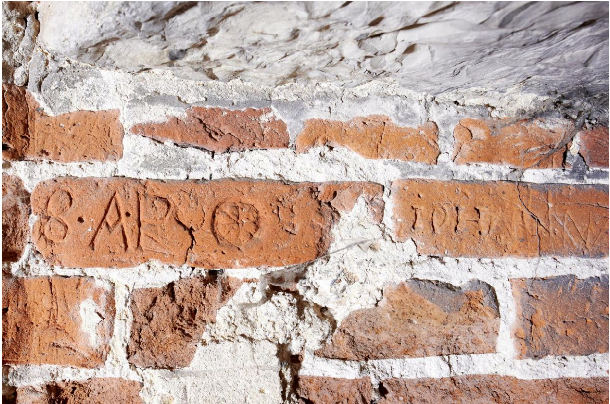
Niveau principal (R+1). Détails des gravures réalisées dans la briques ("A" en compas et équerre, roue de Fortune, noms).
