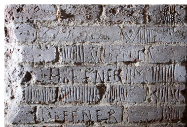
Niveau inférieur. Détails des gravures réalisées dans la brique (bâtons de décompte de jours, noms). Phot. Delphine Volto-Jourdan IVR22_20225900126NUCA
