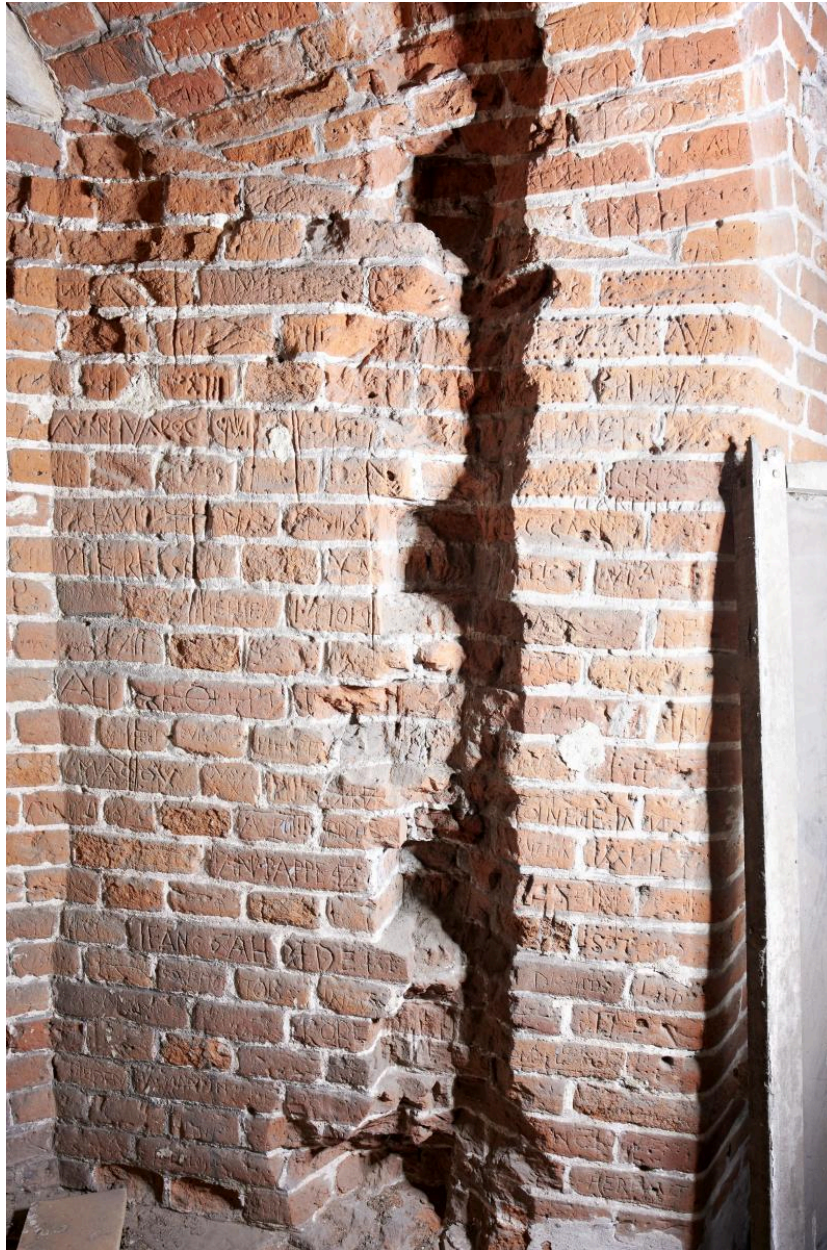
Niveau principal (R+1). Vue générale de l'intrados opposé. Gravures réalisées dans la briques (modification structurelle indéterminée).
