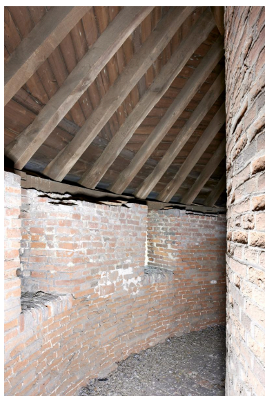
Chemin de ronde. A gauche : ouvertures de tir (fente à rayère et créneau à volet). A droite : mur de la salle circulaire centrale. Phot. Delphine Volto-Jourdan IVR22_20225900156NUCA
