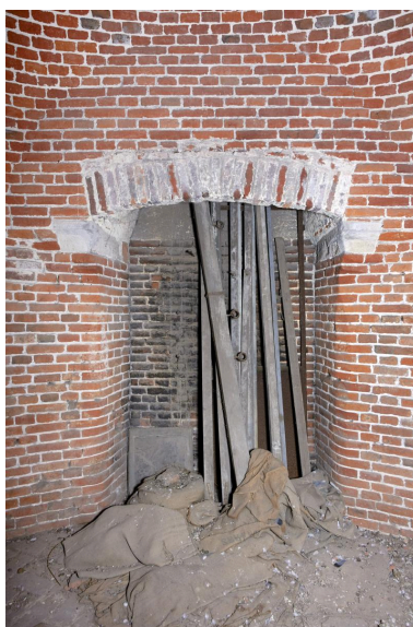
Niveau principal (R+1). Cheminée. Phot. Delphine Volto-Jourdan IVR22_20225900136NUCA
