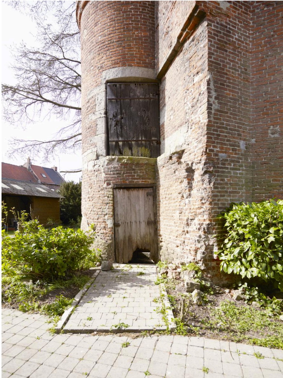
Vue extérieure des deux portes d'accès de la tour d'escalier.
