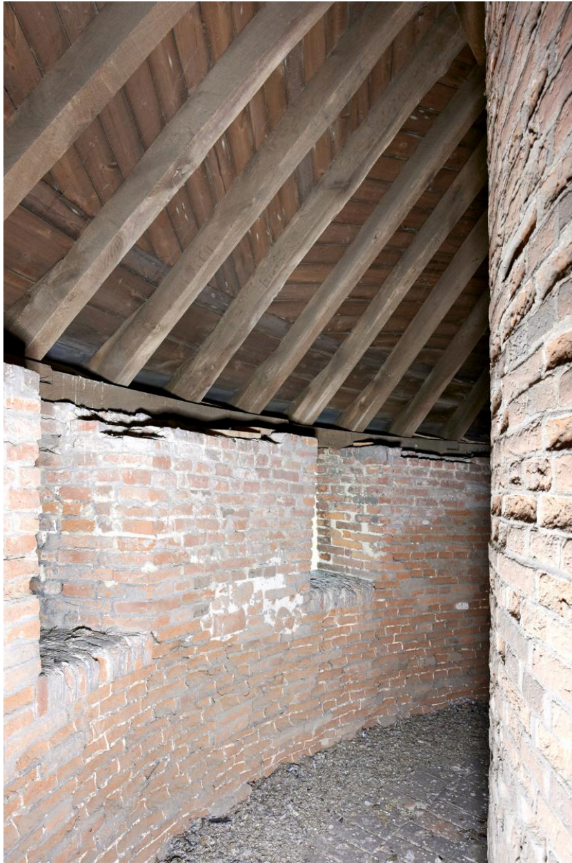
Chemin de ronde. A gauche : ouvertures de tir (fente à rayère et créneau à volet). A droite : mur de la salle circulaire centrale.
