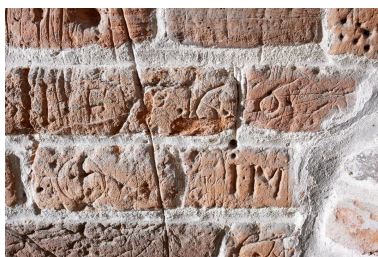
Niveau principal (R+1). Détails des gravures réalisées dans la briques (1606, rue de Fortune, bâtons de décompte de jours). Phot. Delphine Volto-Jourdan IVR22_20225900142NUCA
