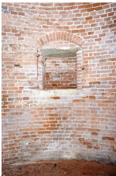
Niveau inférieur. Niche murale. Phot. Delphine Volto-Jourdan IVR22_20225900119NUCA
