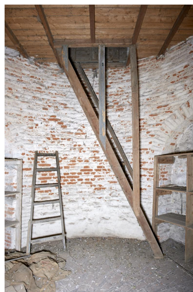
Chemin de ronde. Salle circulaire interne. Echelle de meunier menant à la tour de guet (niveau supérieur). Phot. Delphine Volto-Jourdan IVR22_20225900154NUCA
