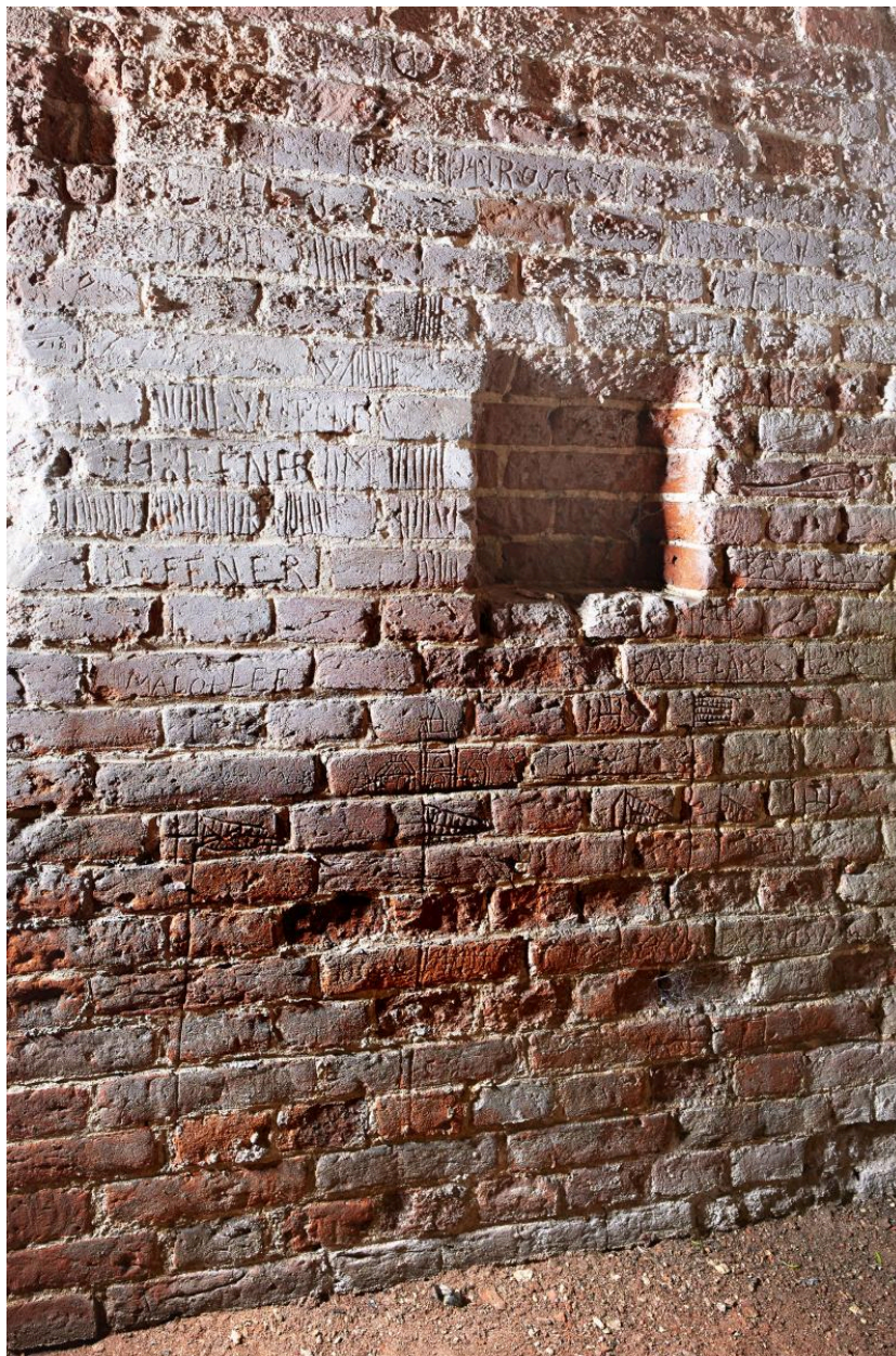
Niveau inférieur. Vue générale de la niche sud-ouest. Gravures réalisées dans la brique.
