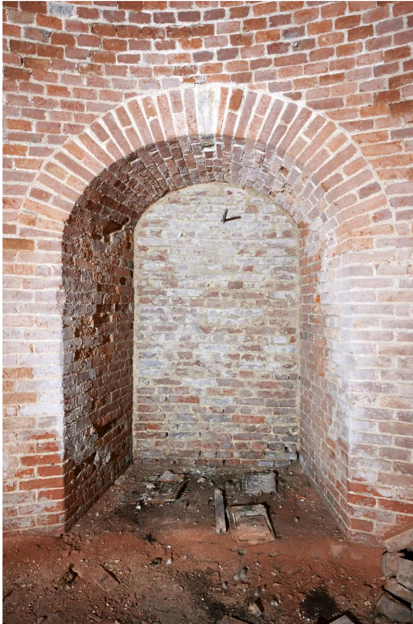
Niveau inférieur. Niche sud-ouest à vocation indéterminée, comblée.
