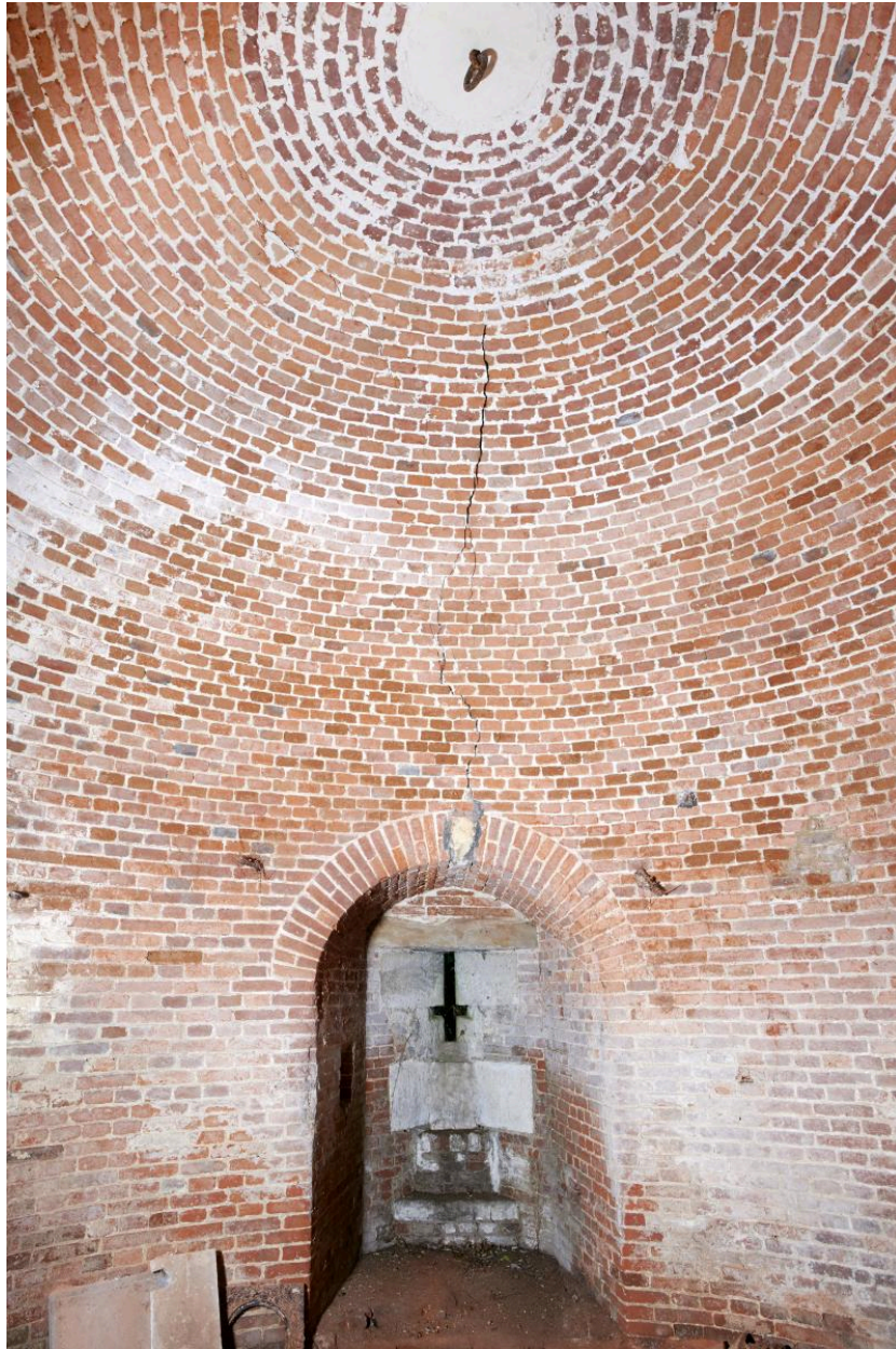
Niveau inférieur. Vue générale de la coupole traitée en plein cintre et de la niche de tir nord-ouest.
