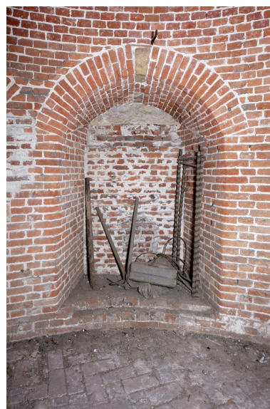
Niveau principal (R+1). Niche de tir sud-ouest comblée. Phot. Delphine Volto-Jourdan IVR22_20225900137NUCA
