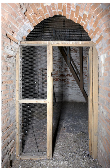
Chemin de ronde. Ouverture en voûte d'ogive donnant accès à la salle circulaire interne. Phot. Delphine Volto-Jourdan IVR22_20225900152NUCA
