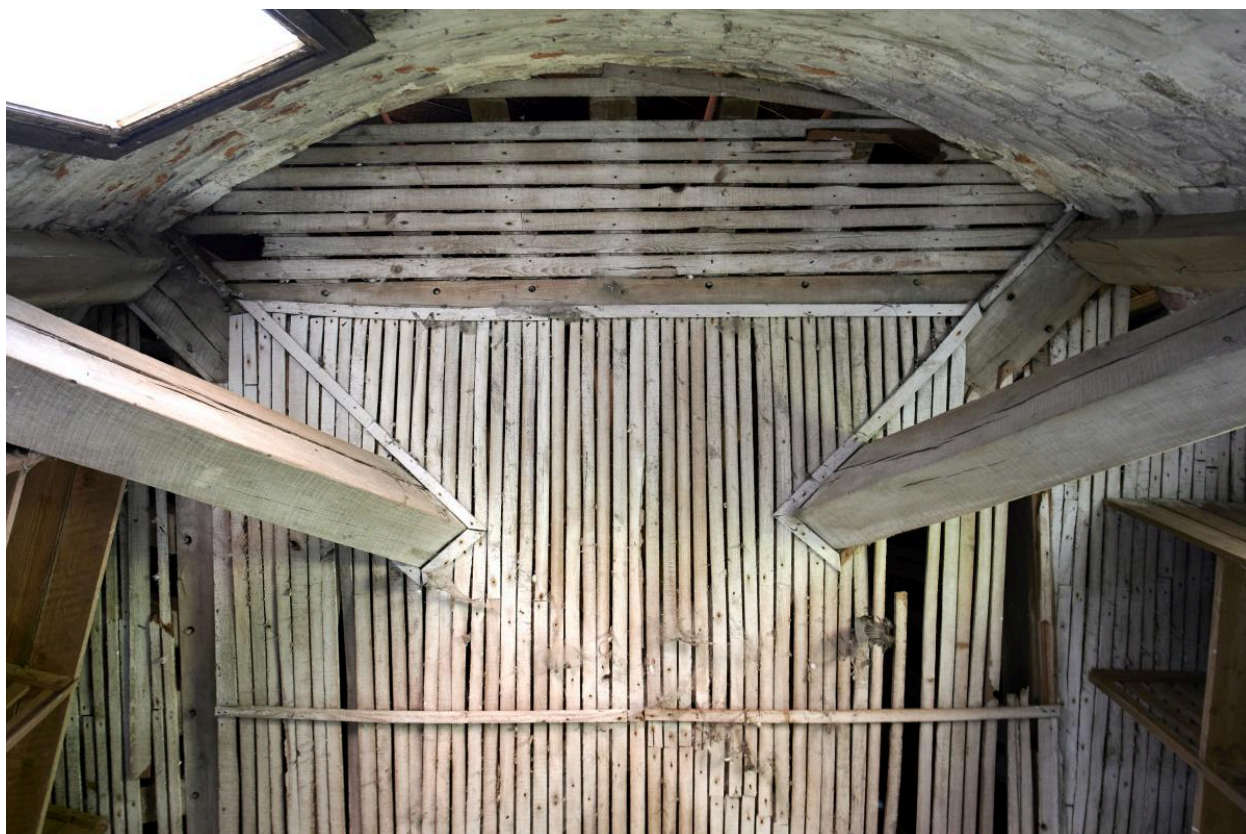
Niveau supérieur. Tour de guet. Détail du plafond en lattis de bois peint.
