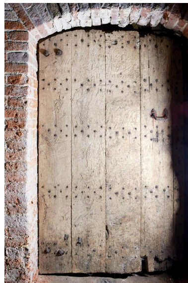
Niveau inférieur. Porte d'accès. Prise de vue générale en lumière rasante (xylographies). Phot. Delphine Volto-Jourdan IVR22_20225900123NUCA
