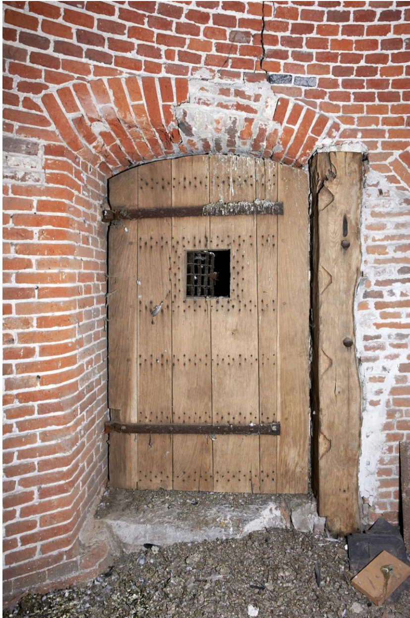
Niveau principal (R+1). Porte d'accès. Vue depuis l'intérieur. Porte à guichet. Poutre en réemploi dans un des piedroits.
