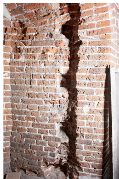
Niveau principal (R+1). Vue générale de l'intrados opposé. Gravures réalisées dans la briques (modification structurelle indéterminée). Phot. Delphine Volto-Jourdan IVR22_20225900144NUCA
