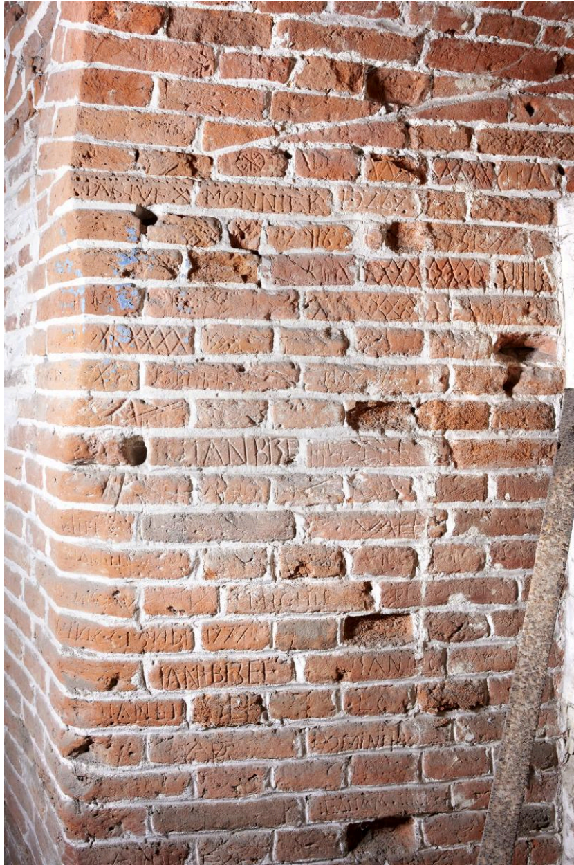
Niveau principal (R+1). Vue générale de gravures réalisées dans la briques d'un intrados d'une des niches de tir (noms, dates, symboles divers, roue de Fortune).
