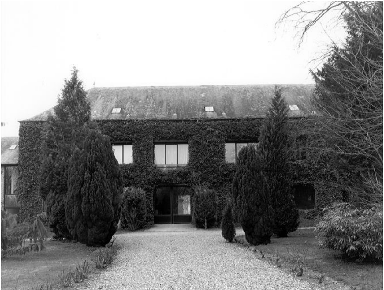
Vue d'ensemble de la façade sur cour.
