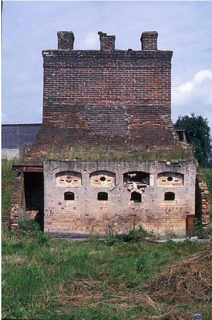
Vue d'ensemble du four de cuisson des verres, 1978 (Coll. Ecomusée des Pays de l'Oise).
