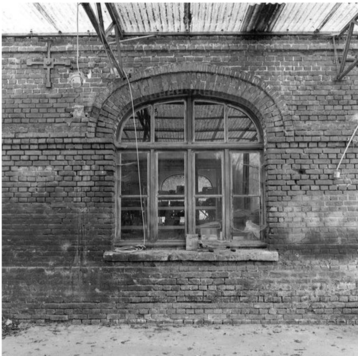
Détail d'une des ouvertures d'origine.
