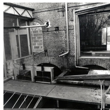
Détail de la double coulerie maçonnée.
