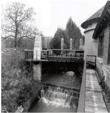
Le vannage de décharge et la chute du moulin. Phot. Thierry Lefébure IVR22_20026001334X
