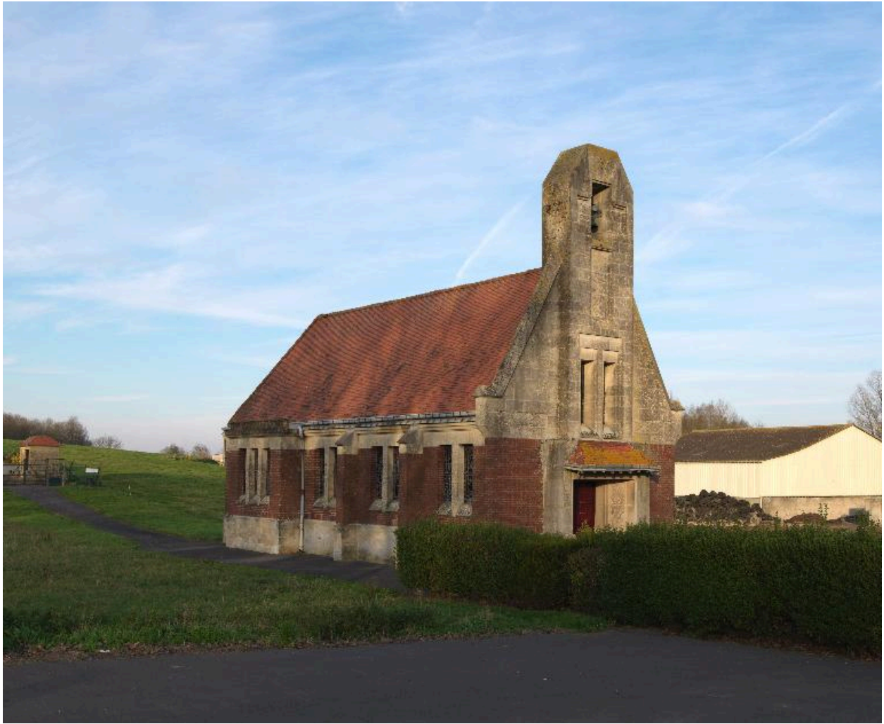
Vue de l'église, depuis le sud-ouest.
