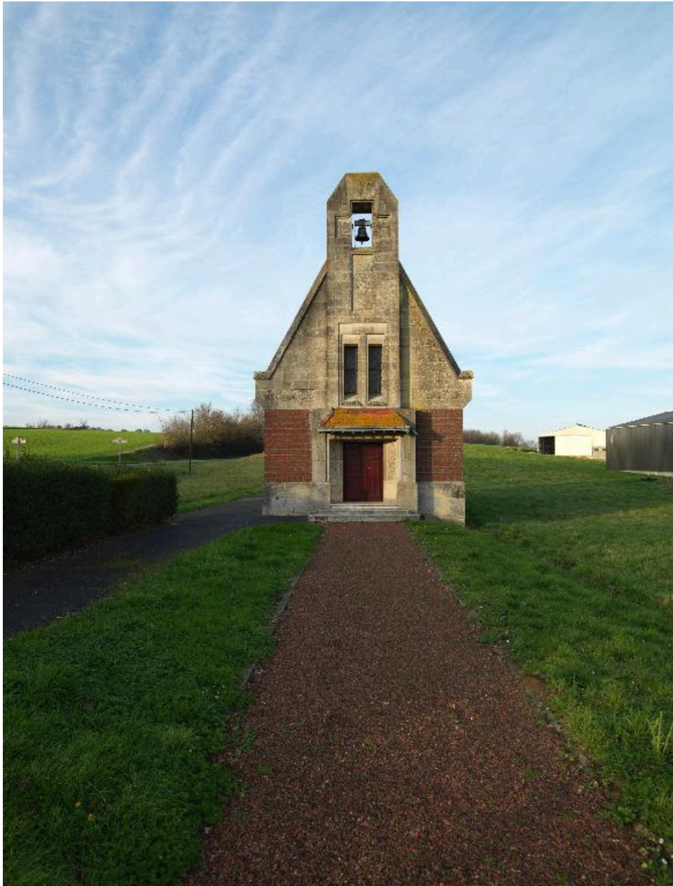
Vue de la façade principale, depuis le sud.
