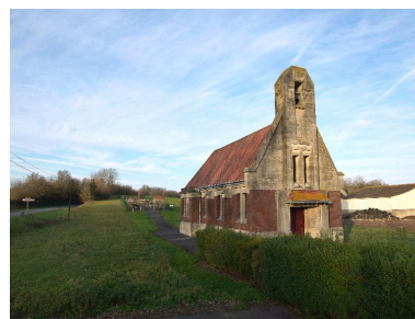
L'église et le cimetière, à l'arrière-plan. Phot. Marie-Laure Monnehay-Vulliet IVR22_20158001027NUC2A
