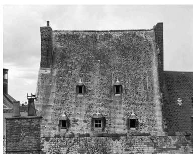
Vue du toit et des lucarnes à la capucine, depuis l'est.
