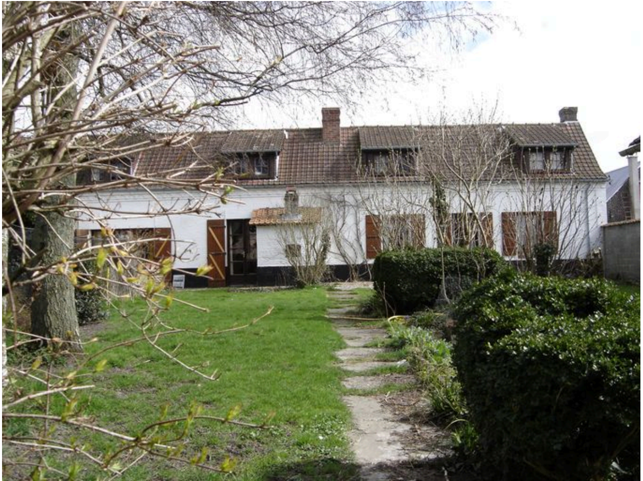
Vue postérieure avec emplacement du fournil en saillie.
