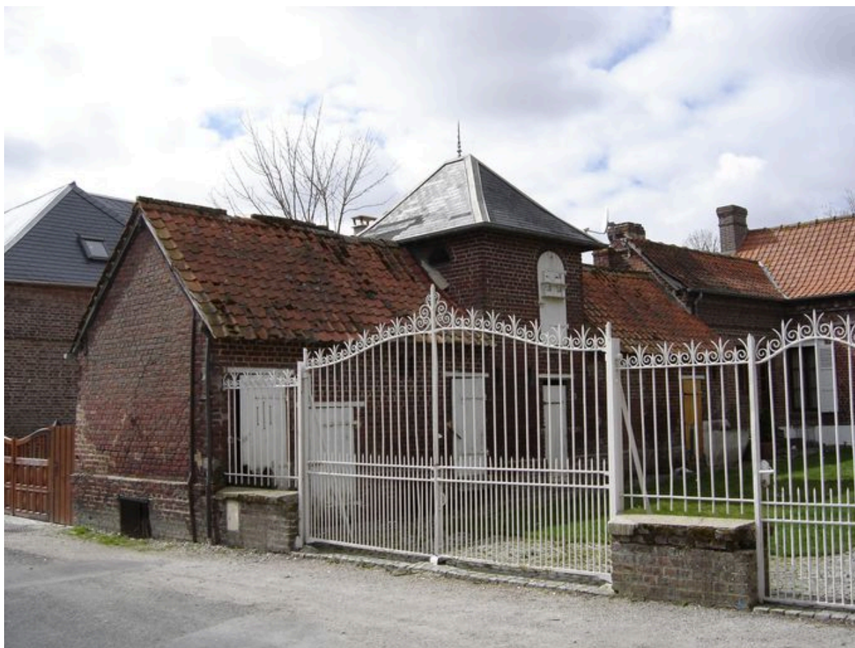
Vue des bâtiments agricoles en retour d'équerre du logis.
