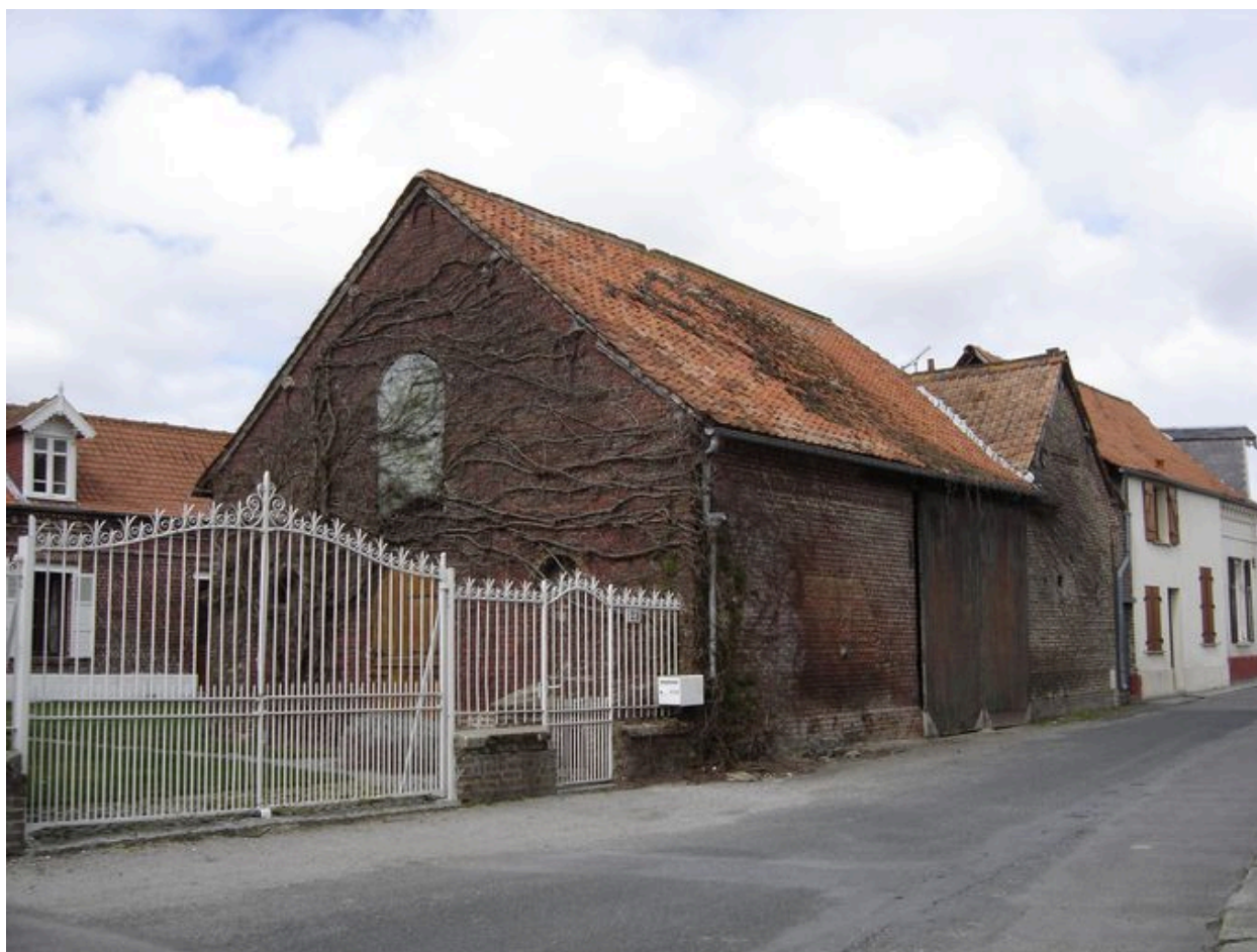
Vue de la grange longeant la rue.
