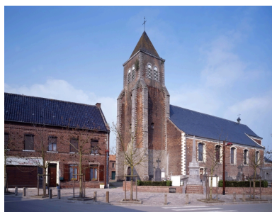
Vue générale depuis la rue de l'Eglise. Phot. Pierre Thibaut IVR31_20095902063VA
