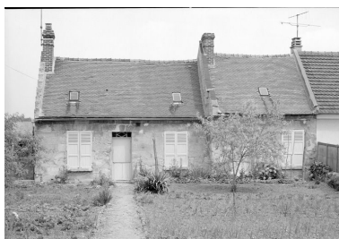
Elévation antérieure. Phot. Jean-Michel Perrin IVR22_19856000782X
