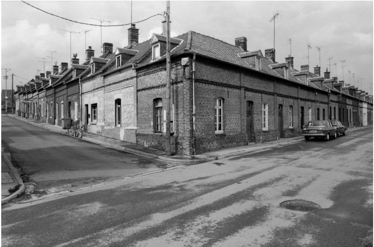
Les logements de la "vieille cité" (80 à 108 cité Saint-Charles), en 1991.
