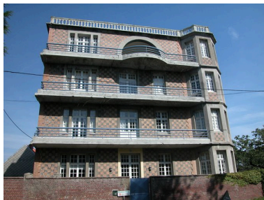
Élévation antérieure. Phot. Elisabeth Justome IVR22_20048001592NUCA
