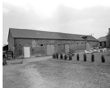
Etables à chevaux et à vaches. Phot. Laurent Jumel IVR22_19980202899X
