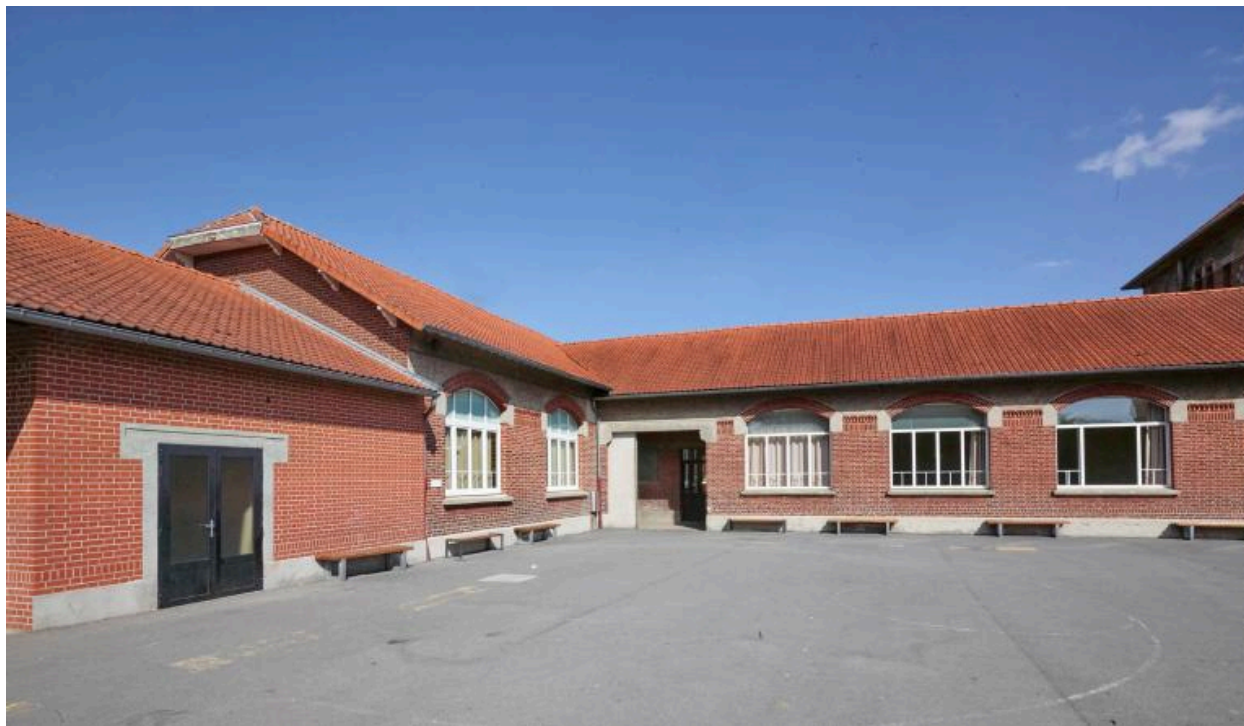
Ecole Carlin, vue des bâtiments sur cour.
