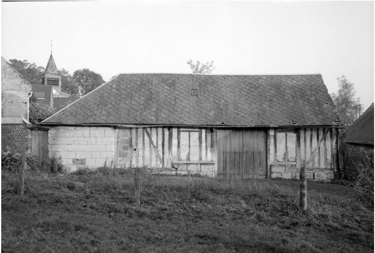
Vue d'une grange (rue Saint-Martin).
