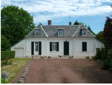
Vue générale. Phot. Frédéric Fournis IVR22_20108001919NUCA
