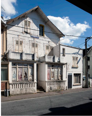
Vue générale. Phot. Pierre Thibaut IVR31_20146202209NUCA
