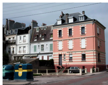
Élévations postérieures des habitations dites Coup de Vent, Les Fleurs, Faust et Glen Rock. Phot. Elisabeth Justome IVR22_20048001444NUCA
