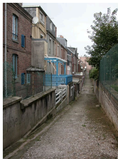
Ruelle des Matelots, façades arrières des maisons de la rue Jules-Barni, vue depuis le sud. Phot. Elisabeth Justome IVR22_20058003431NUCA
