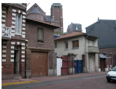
Garages, 22 et 24 rue Jules-Barni (1982 AH 781-783). Phot. Elisabeth Justome IVR22_20058003460NUCA
