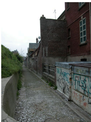
Ruelle des Matelots, façades arrières des maisons de la rue Jules-Barni, vue depuis le nord. Phot. Elisabeth Justome IVR22_20058003430NUCA
