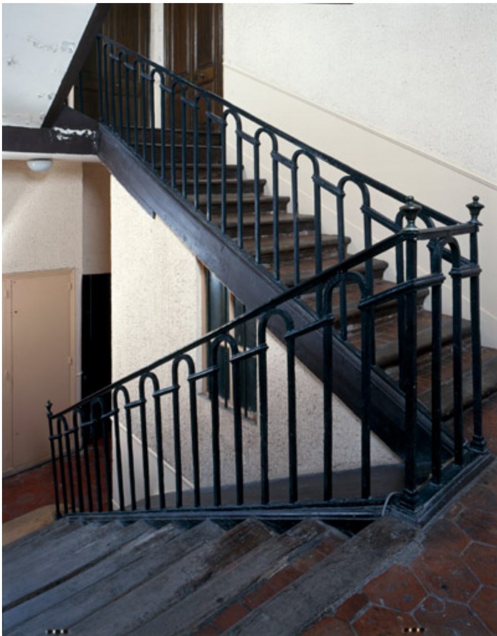
L'escalier du logis sur rue.
