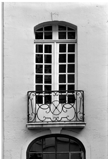
Garde corps du logis en fond de cour. Phot. Thierry Lefébure IVR22_19940202677X
