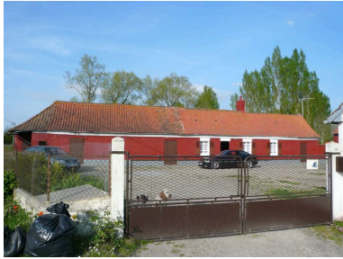
Vue du logis et de l'écurie dans son prolongement. Phot. Inès Guérin IVR22_20078005923NUCA
