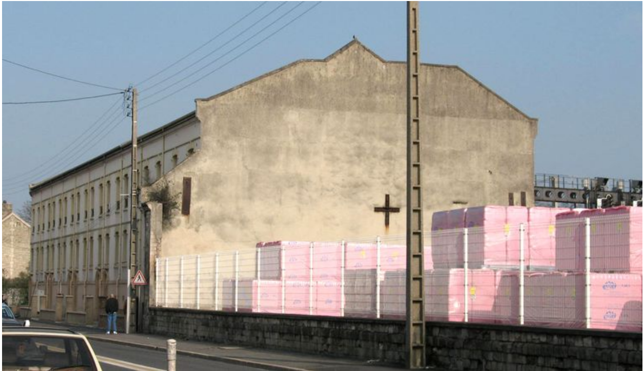
Mur pignon ouest des logements.
