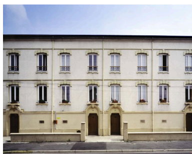
Détail des travées de la barre de logements. Phot. Thierry Lefébure IVR22_20076000106VA
