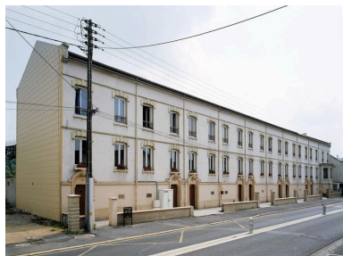
Vue générale de la barre de logements d'ouvriers de l'usine Saxby. Phot. Thierry Lefébure IVR22_20076000107VA
