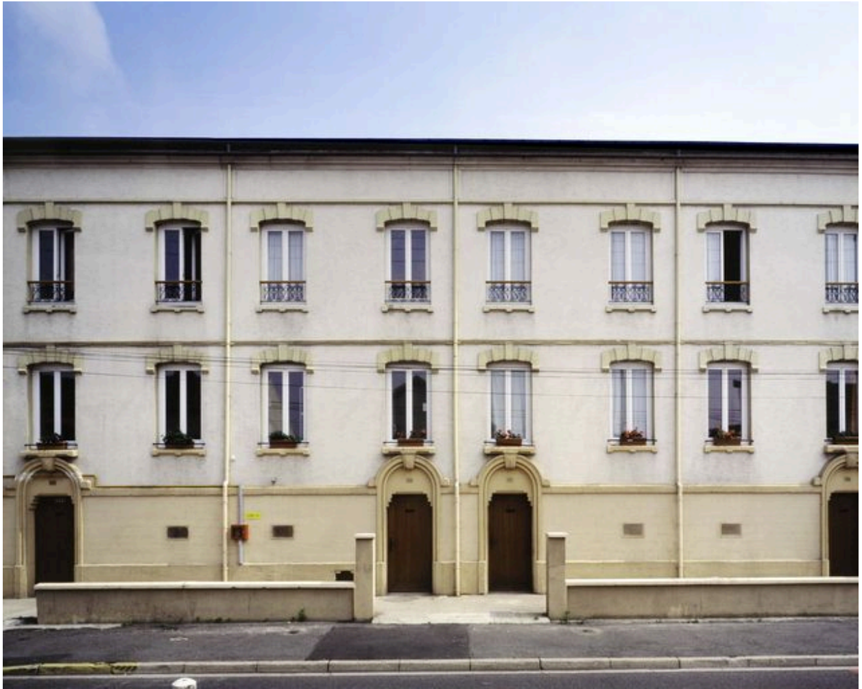
Détail des travées de la barre de logements.
