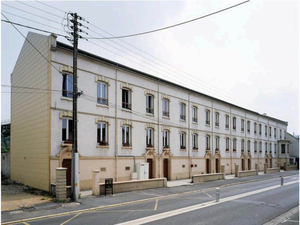
Vue générale de la barre de logements d'ouvriers de l'usine Saxby.
