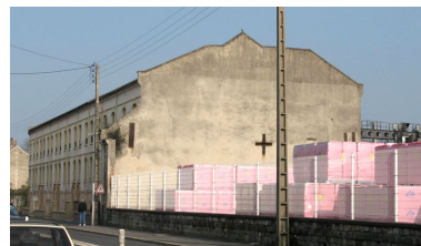
Mur pignon ouest des logements. Phot. Clarisse Lorieux IVR22_20076005097NUCA
