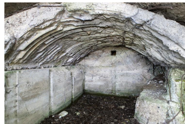
Casemate n°1, Vue intérieure Phot. Jean-Marc Ramette IVR32_20166200275NUCA
