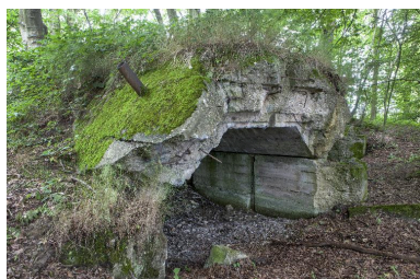
Casemate n°2, vers le nord Phot. Jean-Marc Ramette IVR32_20166200279NUCA
