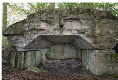
Casemate n°1, vue intérieure Phot. Jean-Marc Ramette IVR32_20166200277NUCA
