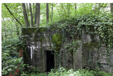
Casemate n°3, élévation antérieure, partie sud. Phot. Jean-Marc Ramette IVR32_20166200269NUCA
