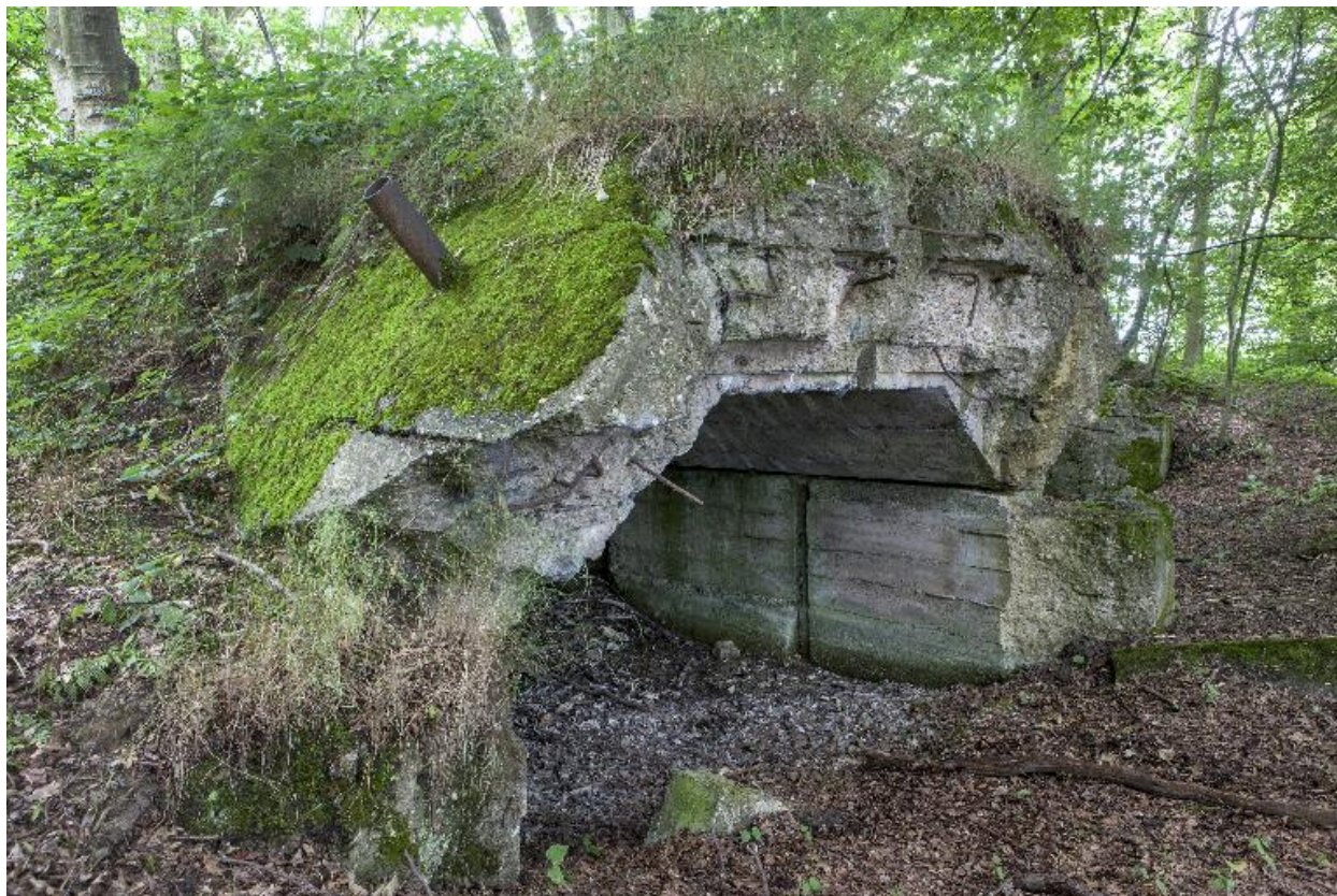
Casemate n°2, vers le nord
