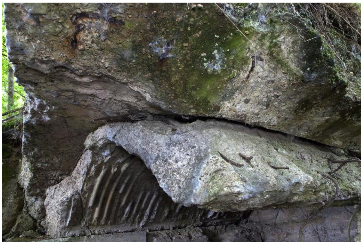
Casemate n°1, détail de la voûte
