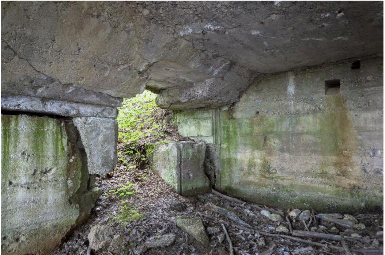
Casemate n°2, Vue intérieure
