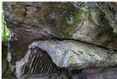
Casemate n°1, détail de la voûte Phot. Jean-Marc Ramette IVR32_20166200276NUCA
