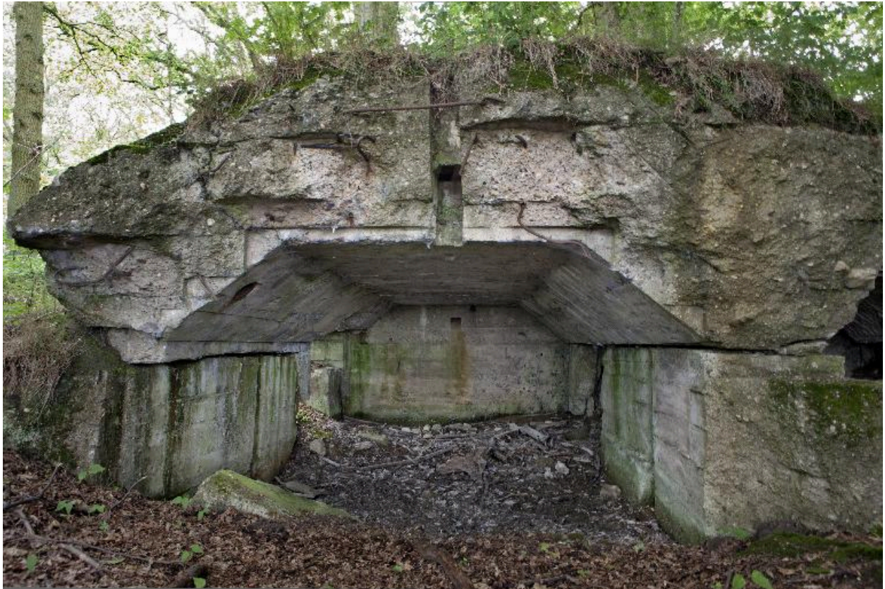
Casemate n°1, vue intérieure
