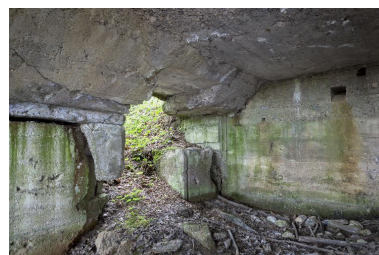
Casemate n°2, Vue intérieure Phot. Jean-Marc Ramette IVR32_20166200278NUCA
