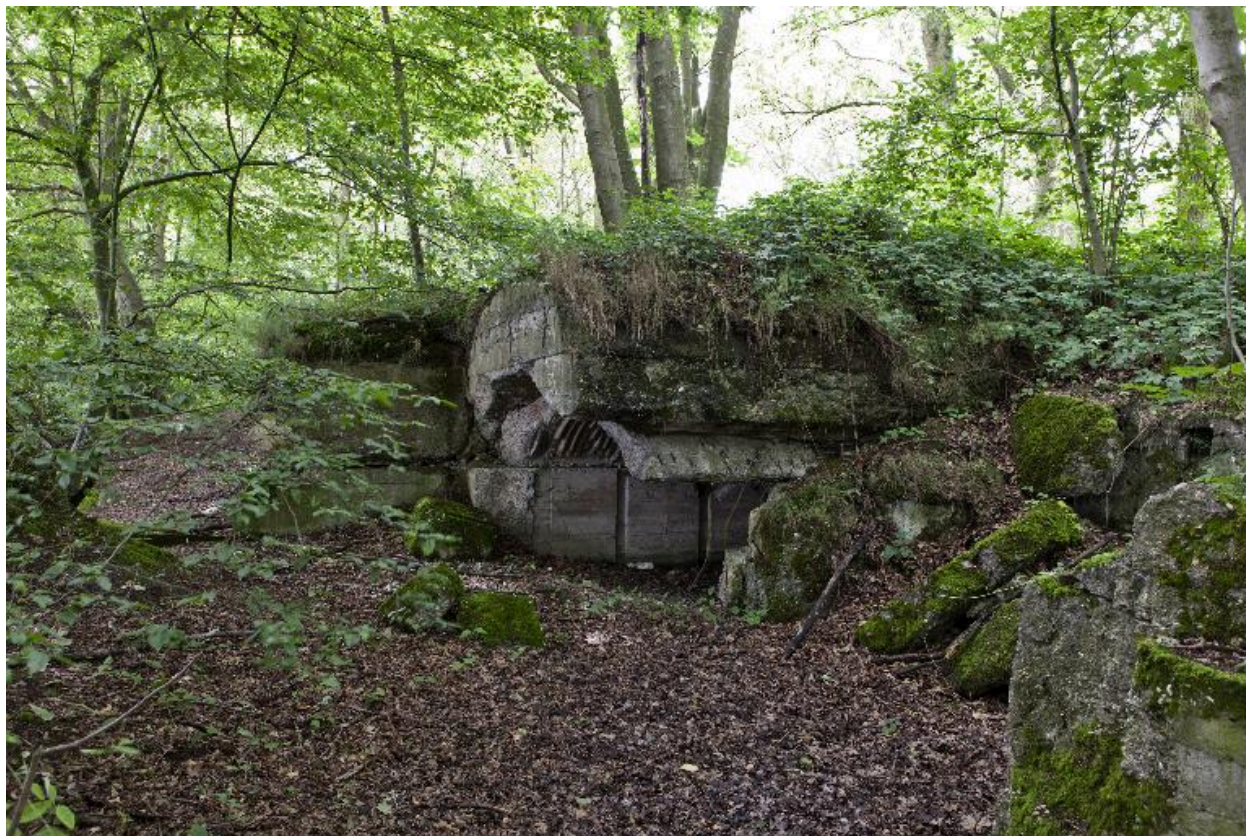
Casemate n°1, vers le sud-ouest
