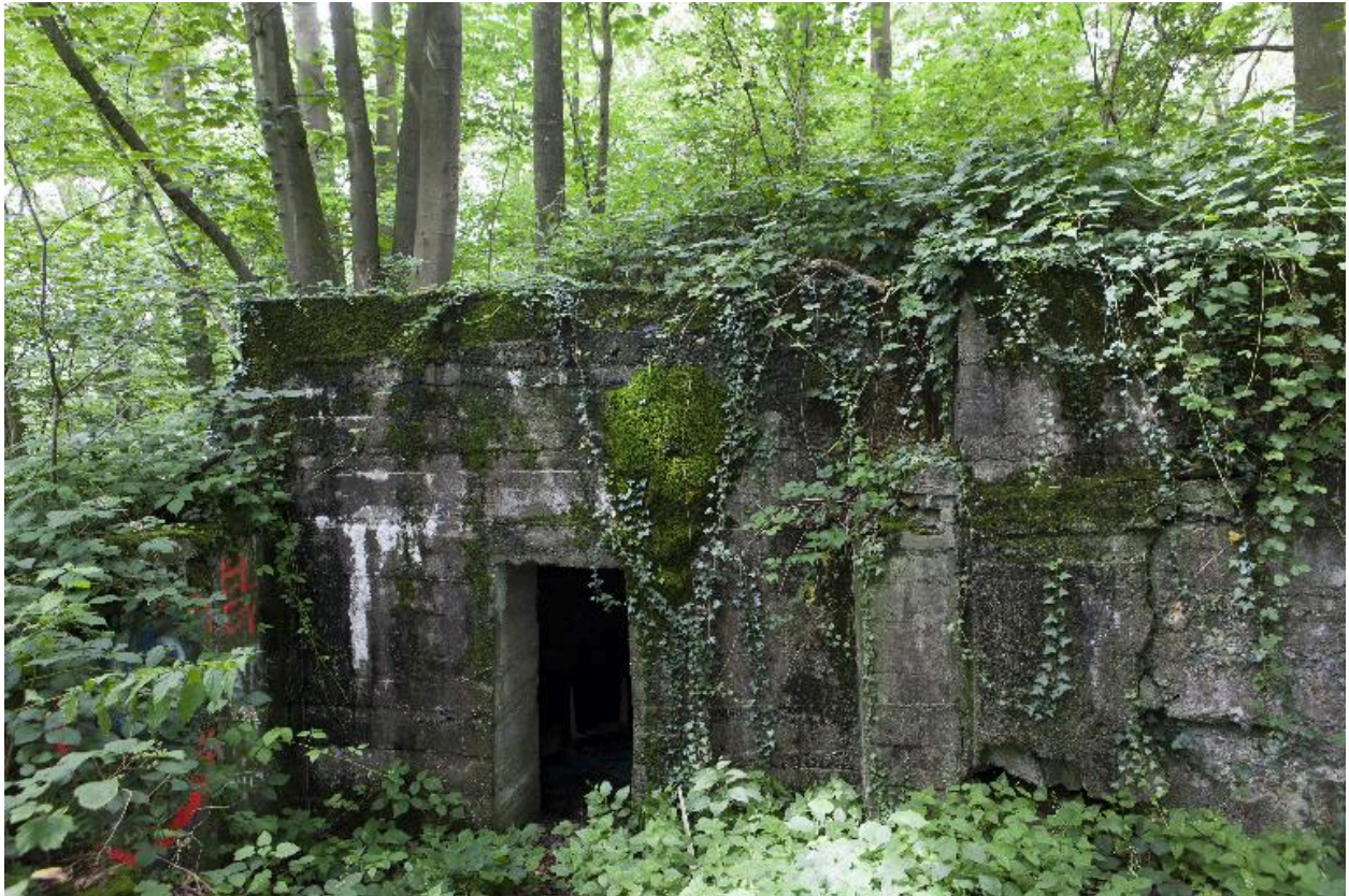
Casemate n°3, élévation antérieure, partie sud.
