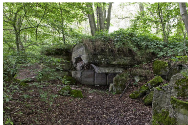
Casemate n°1, vers le sud-ouest Phot. Jean-Marc Ramette IVR32_20166200274NUCA
