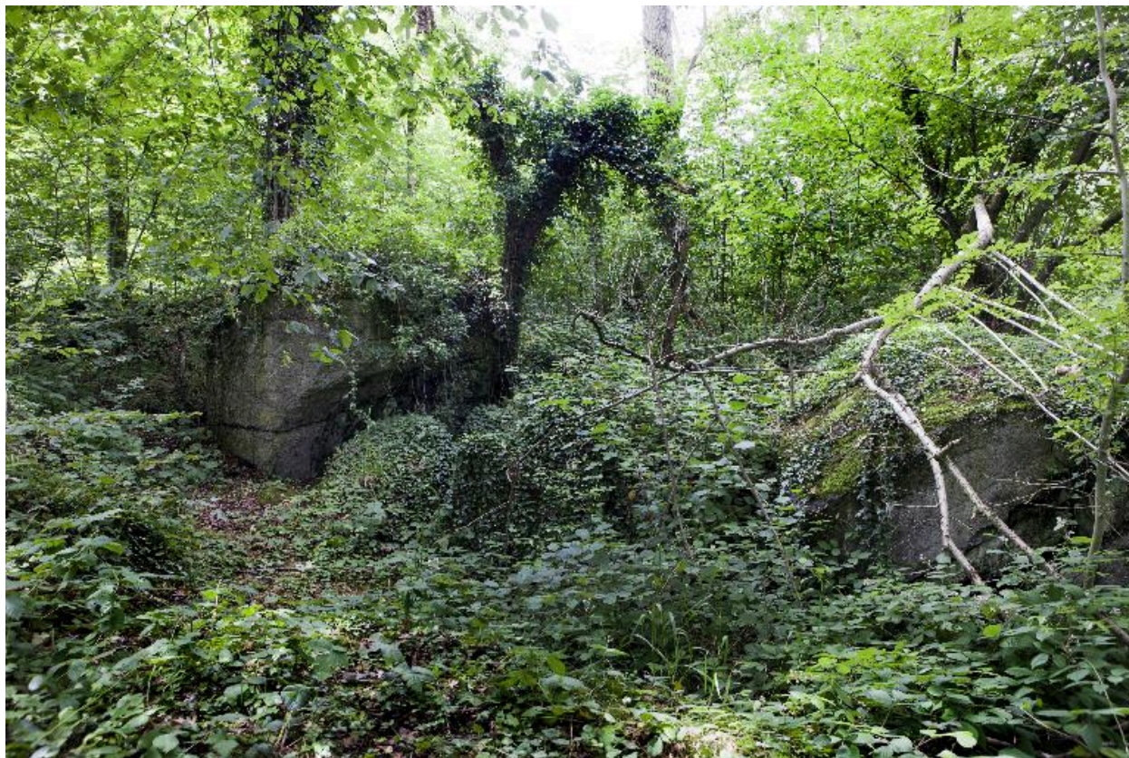
Casemate n°4, vers le sud-ouest
