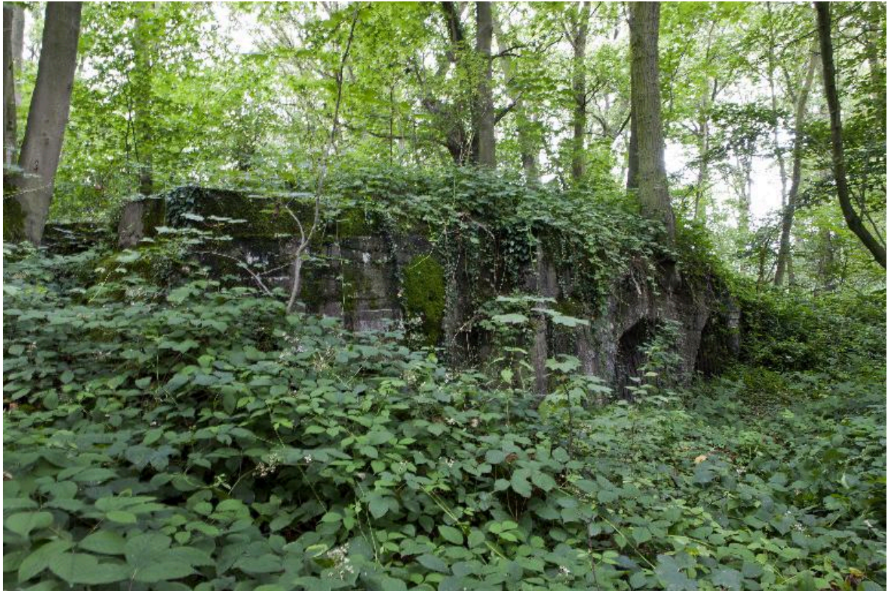
Casemate n°3, élévation antérieure
