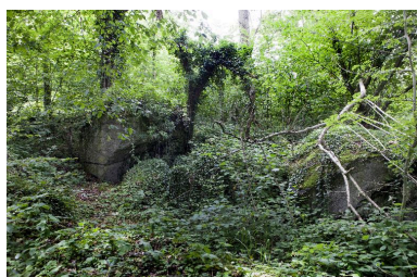
Casemate n°4, vers le sud-ouest Phot. Jean-Marc Ramette IVR32_20166200273NUCA
