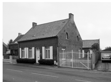
Vue générale d'une maison élémentaire.
