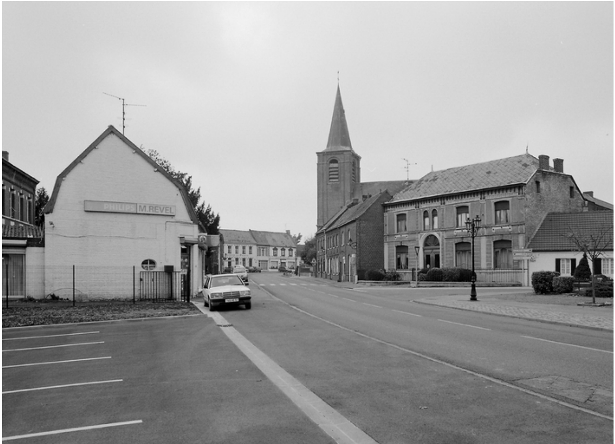
Vue générale vers l'église.
