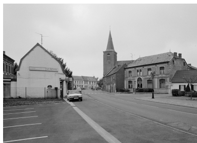
Vue générale vers l'église. Phot. Philippe Dapvril IVR31_20045900684X
