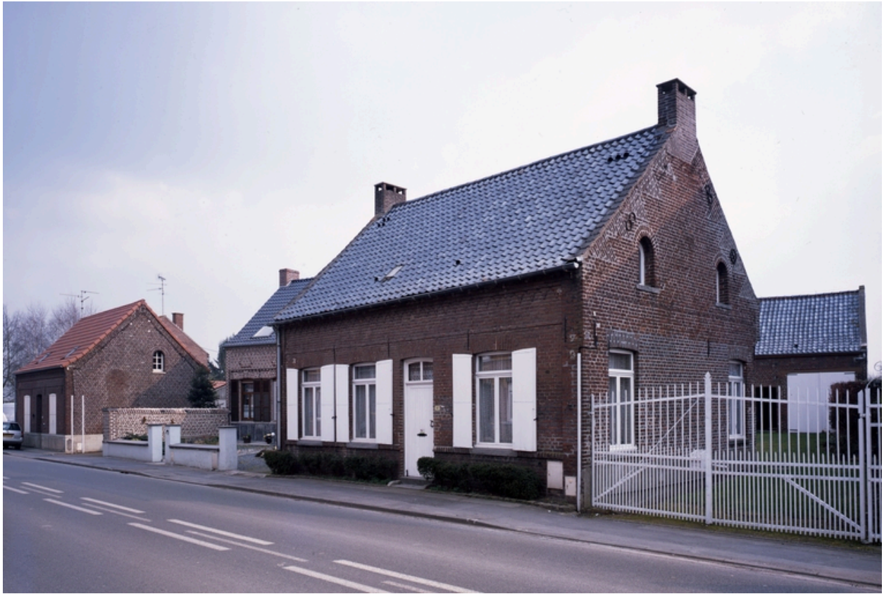
Vue générale d'une maison élémentaire.
