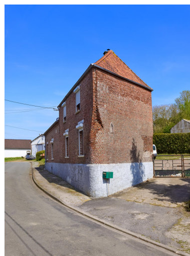
Ferme, rue de Pétilion. Phot. Thierry Lefébure IVR32_20236200351NUCA
