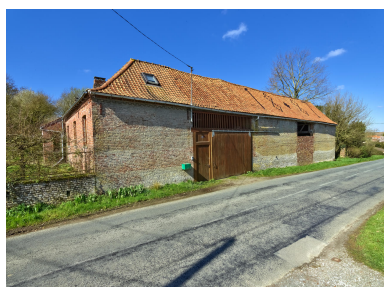
Ferme en brique et tuile, datée de 1887, rue Haute. Phot. Thierry Lefébure IVR32_20236200340NUCA
