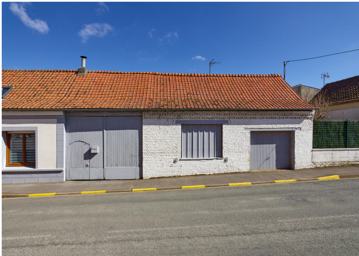
Ancienne porte charretière avec porte piétonne, rue de Saint-Pol.
