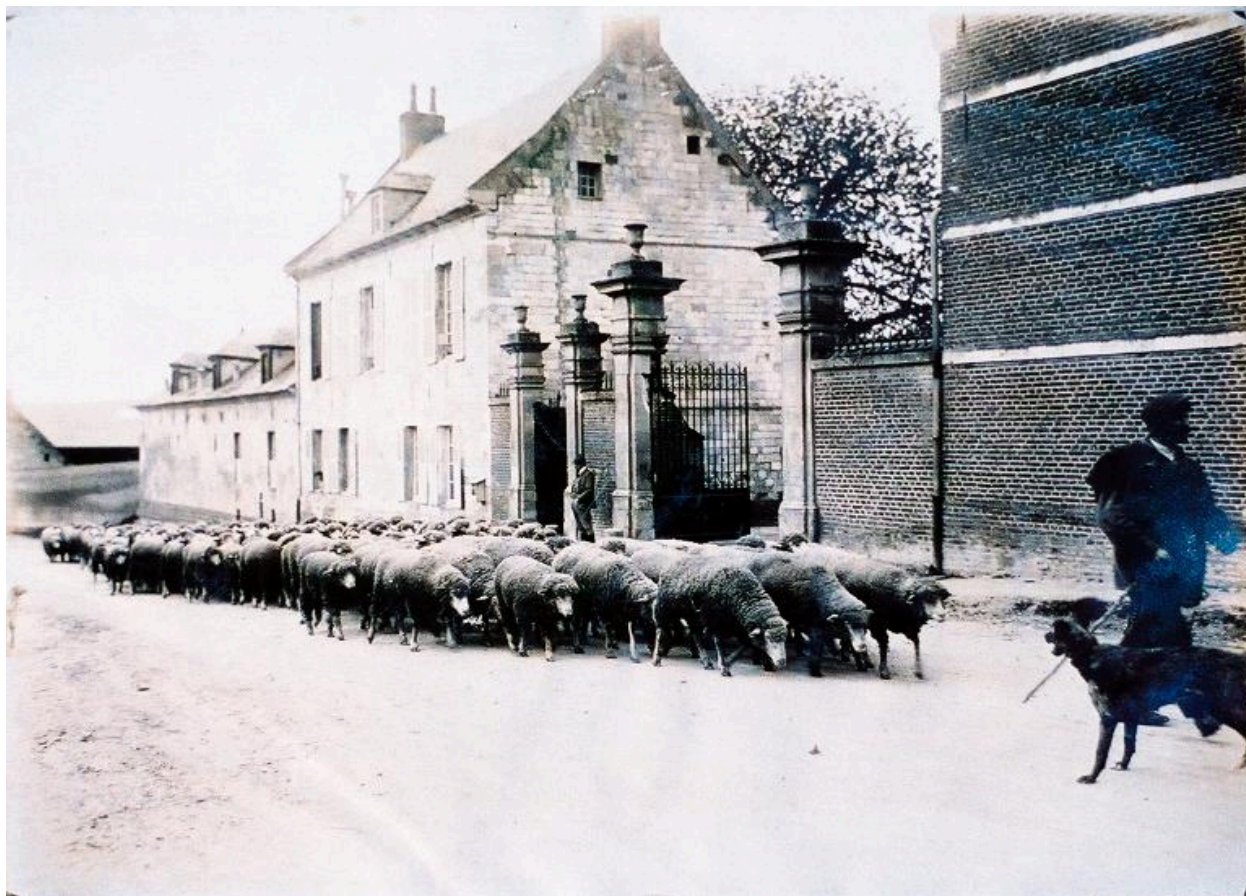
Bâtiments d'entrée, avant 1914 (AD Somme ; 10 R 501).
