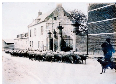
Bâtiments d'entrée, avant 1914 (AD Somme ; 10 R 501).
