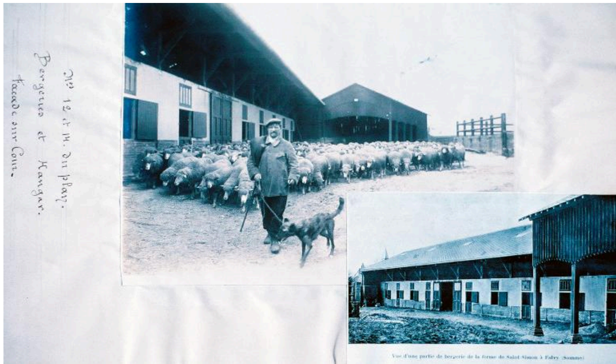
Bergerie et Hangar. Façade sur cour, avant 1914 (AD Somme ; 10 R 501).
