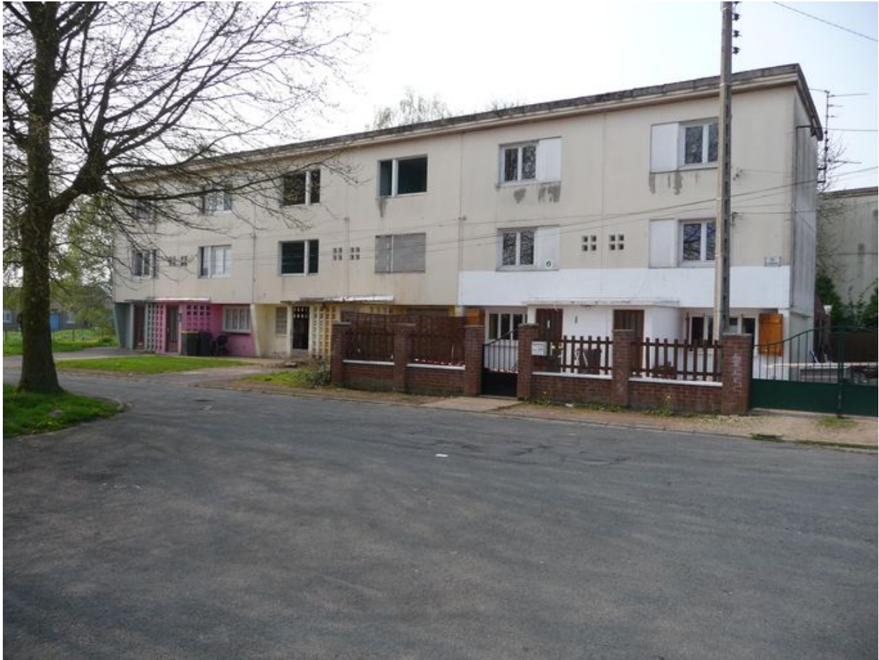
Vue générale d'un groupe de six logements.
