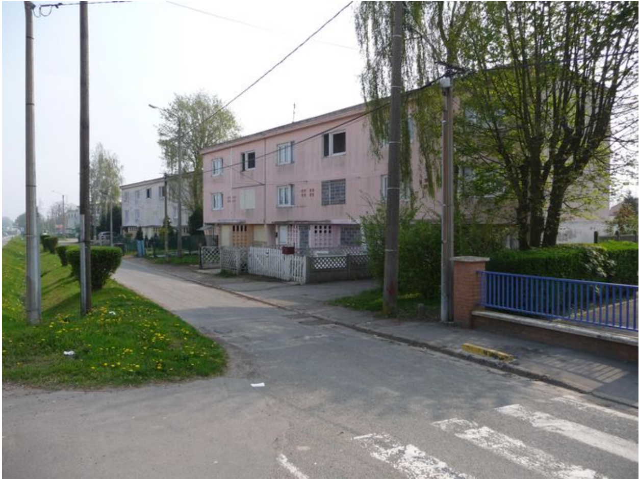
Vue générale d'un groupe de six logements.
