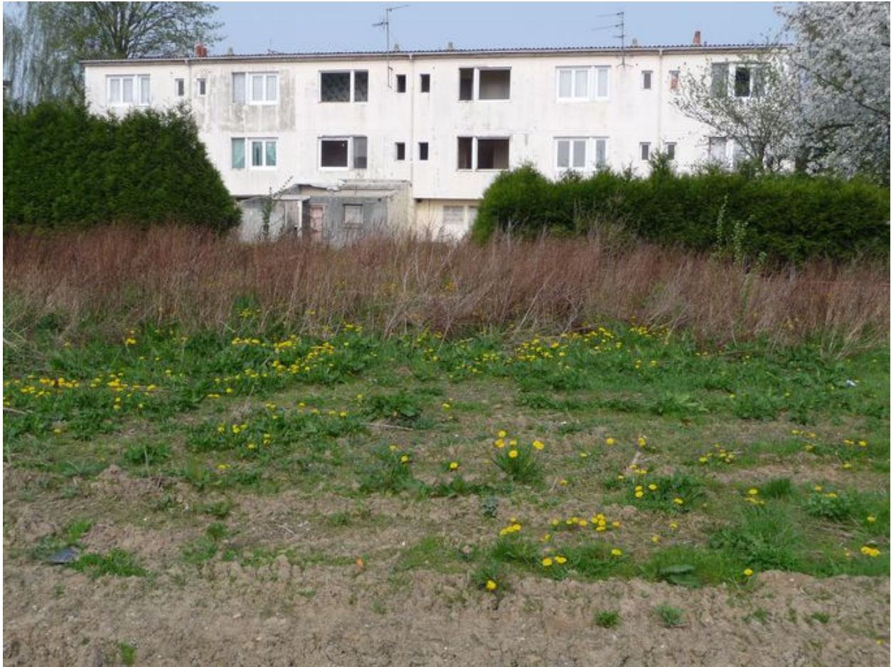
Vue générale d'un groupe de six logements.
