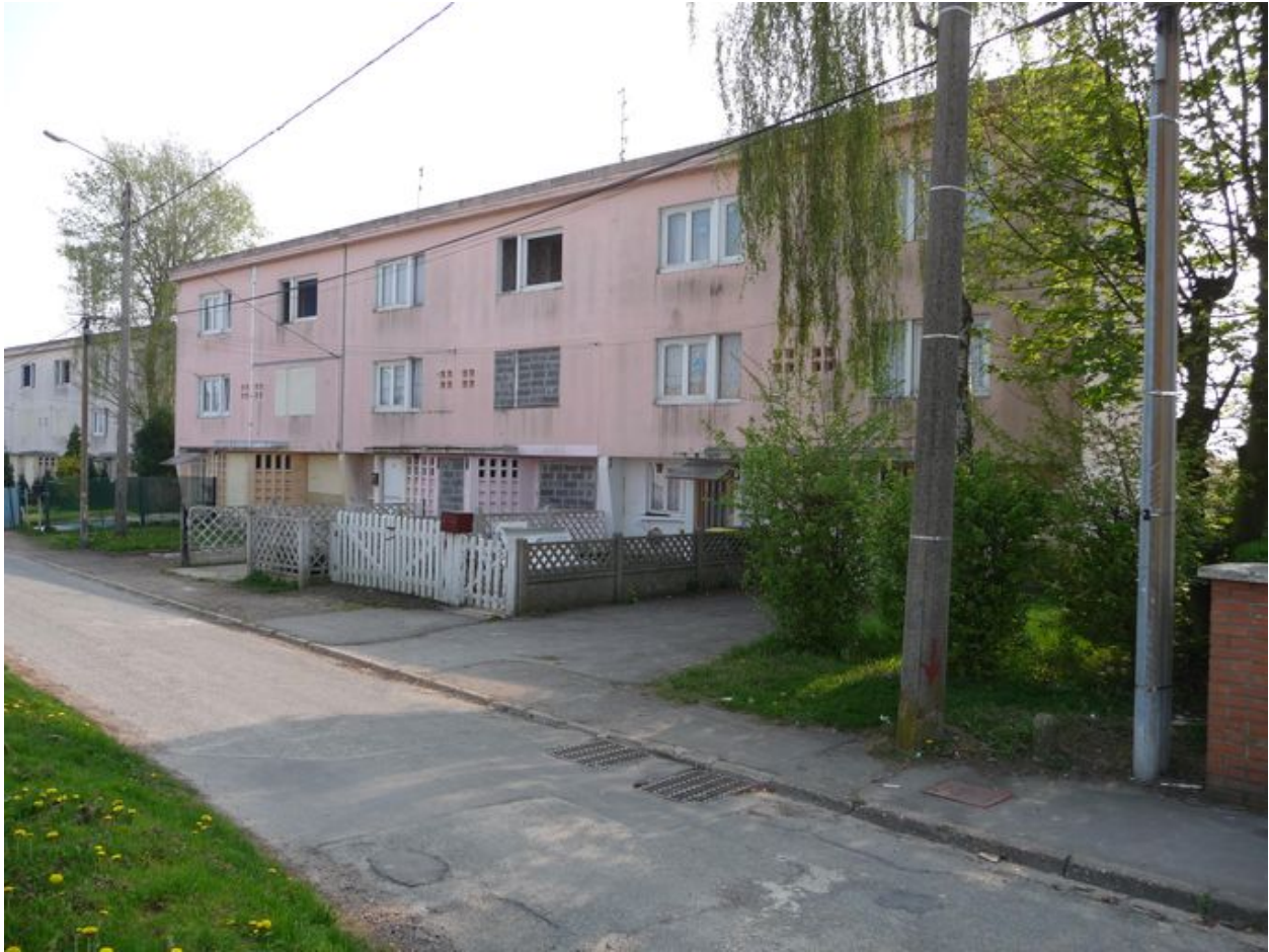
Vue générale d'un groupe de six logements.
