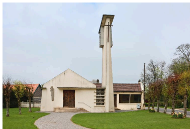
Vue générale de face. Phot. Hubert Bouvet IVR31_20146203342NUC4A
