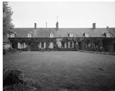
Elévation antérieure sur le jardin. Phot. Jean-Michel Perrin IVR22_19856000820V
