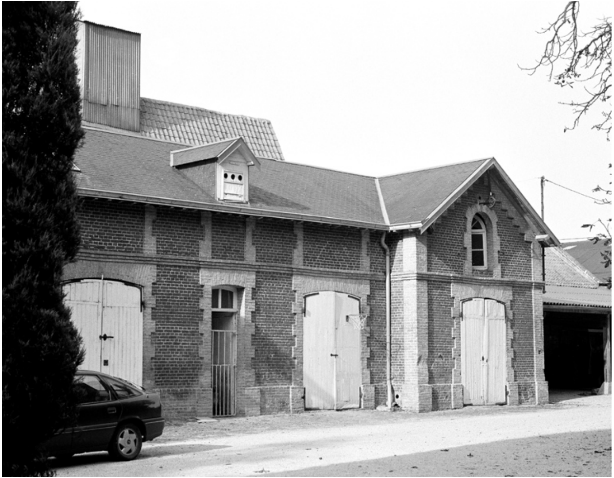
Vue du bâtiment en brique, au nord de la maison.
