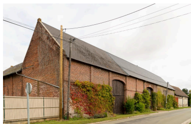
Vue des bâtiments agricoles alignés sur la rue depuis le sud-ouest. Phot. Marc Kérignard IVR32_20216001118NUCA
