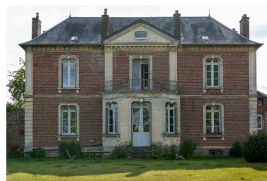
Vue générale du logis depuis le nord. Phot. Marc Kérignard IVR32_20216001189NUCA
