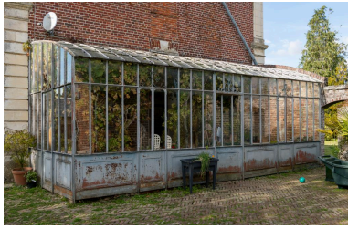
Serre contre le pignon est du logis. Phot. Marc Kérignard IVR32_20216001186NUCA
