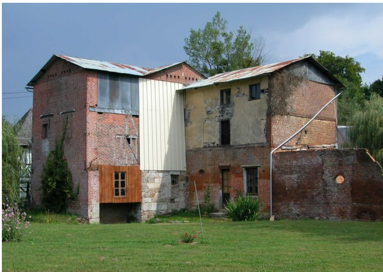
Vue d'ensemble sud du moulin.
