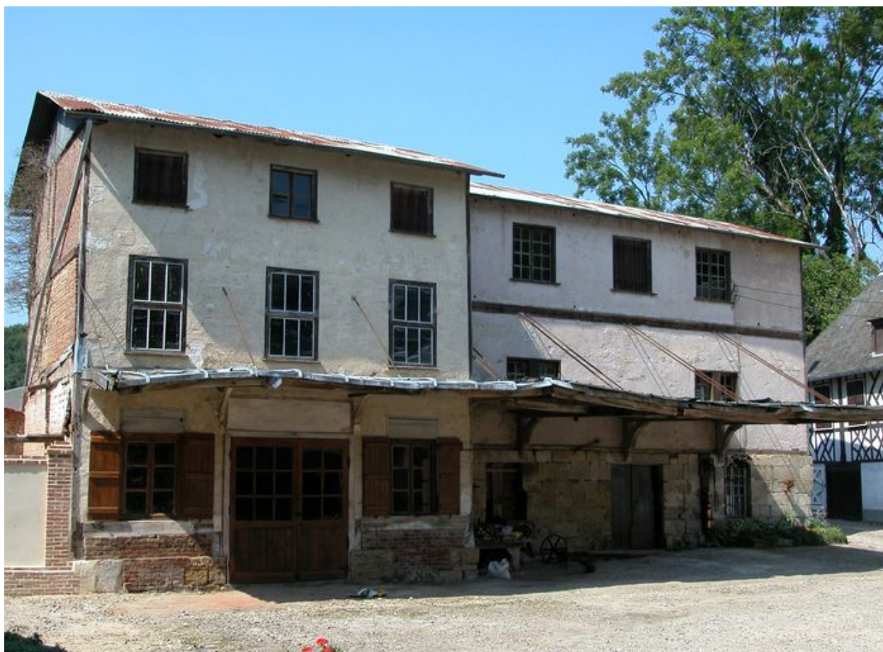
Façade sur cour du moulin.
