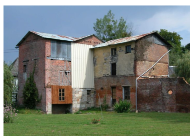
Vue d'ensemble sud du moulin.
