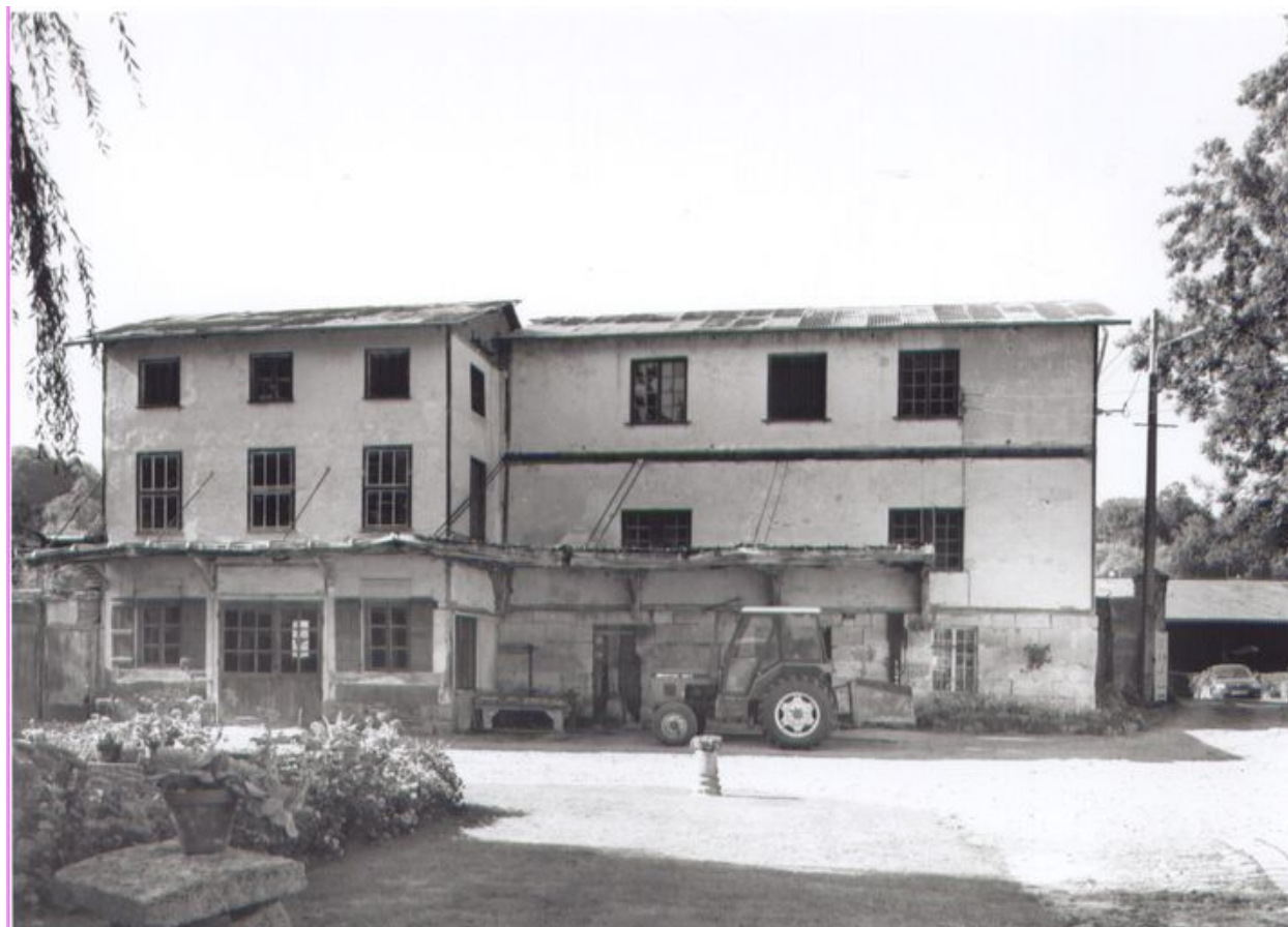
Façade sur cour du moulin.
