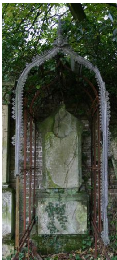
Stèle épaulée et auvent-verrière. Phot. Caroline Vincent IVR22_20068001603NUCA
