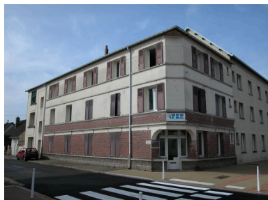
Vue d'ensemble du corps de bâtiment le plus ancien. Phot. Elisabeth Justome IVR22_20058003826NUCA
