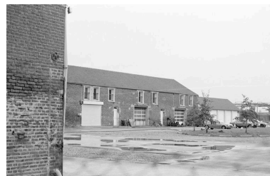
Façade sur cour de l'ancienne bouverie. Phot. Bertrand Fournier IVR22_19996001432Z
