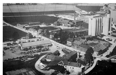
Vue aérienne de la brasserie Peters, vers 1980 (AP). Phot. Bertrand Fournier IVR22_19996001495ZB
