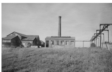
Vue de la chaufferie et du transporteur aérien, vers 1950 (AP). Phot. Bertrand Fournier IVR22_19996001497ZB
