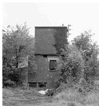
Transformateur électrique. Phot. Bertrand Fournier
