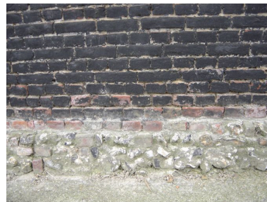
Détail du solin de la grange. Phot. Inès Guérin IVR22_20058005032NUCA
