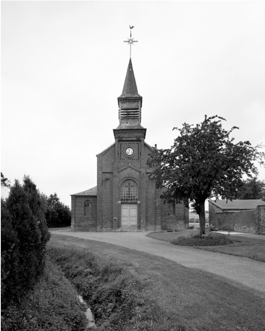
Vue générale de la façade.
