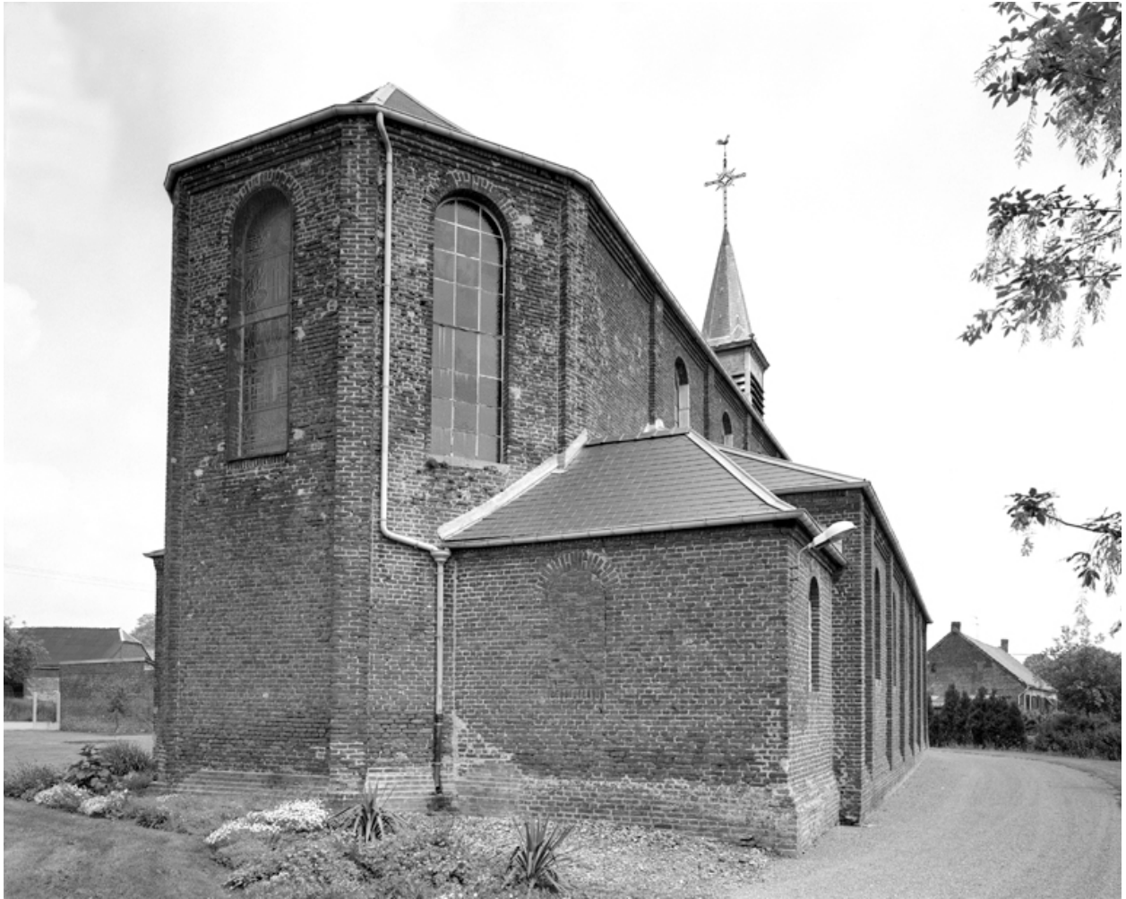
Vue d'ensemble du chevet et de l'élévation sud-ouest.
