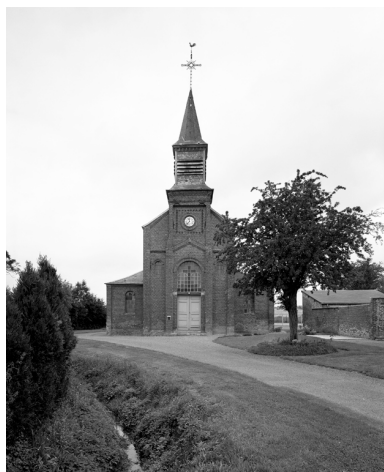
Vue générale de la façade. Phot. Thierry Lefébure IVR22_19910201065V
