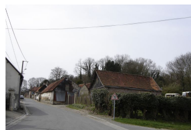
Vue générale depuis le nord. Phot. Inès Guérin IVR22_20058005695NUCA
