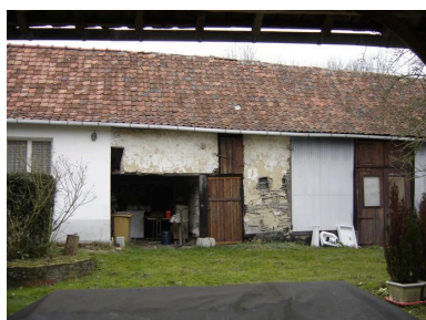
Vue du bâtiment agricole situé dans le prolongement du logis en fond de cour. Phot. Inès Guérin IVR22_20058005007NUCA
