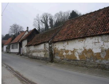
Vue des bâtiments agricoles sur rue. Phot. Inès Guérin IVR22_20058005003NUCA
