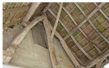
Détail de la charpente du passage couvert. La porte située dans le pignon permet d'atteindre le grenier situé au-dessus du logis sur rue. Phot. Inès Guérin IVR22_20058005008NUCA
