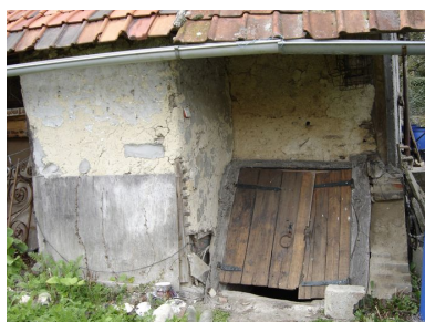
Détail de l'accès à la cave située au nord de la cour. Phot. Inès Guérin IVR22_20058005701NUCA
