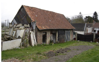
Bâtiment situé à l'est de la propriété. Phot. Inès Guérin IVR22_20058005702NUCA
