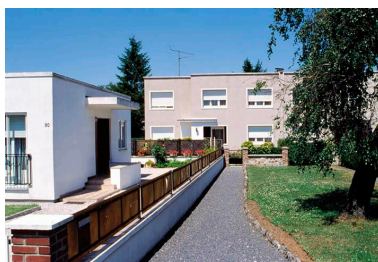
Vue générale du n° 78. Phot. Thierry Petitberghien IVR31_19945901174ZA
