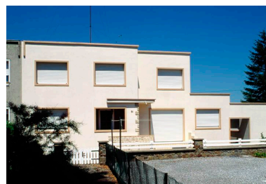
Vue générale d'un logement, n° 84. Phot. Thierry Petitberghien IVR31_19945901179ZA
