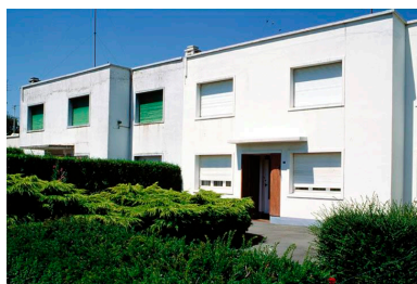
Vue générale du n° 70. Phot. Thierry Petitberghien IVR31_19945901172ZA
