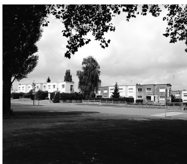
Vue partielle de l'alignement. Phot. Thierry Petitberghien IVR31_20025902038X
