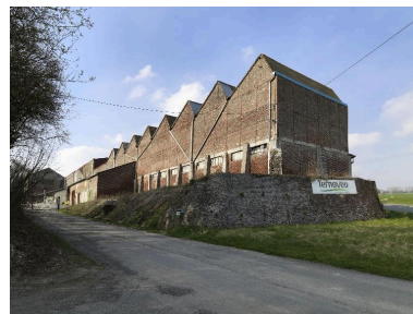
Atelier de traitement des phosphates. Phot. Thierry Lefébure IVR22_20158000225NUC2A
