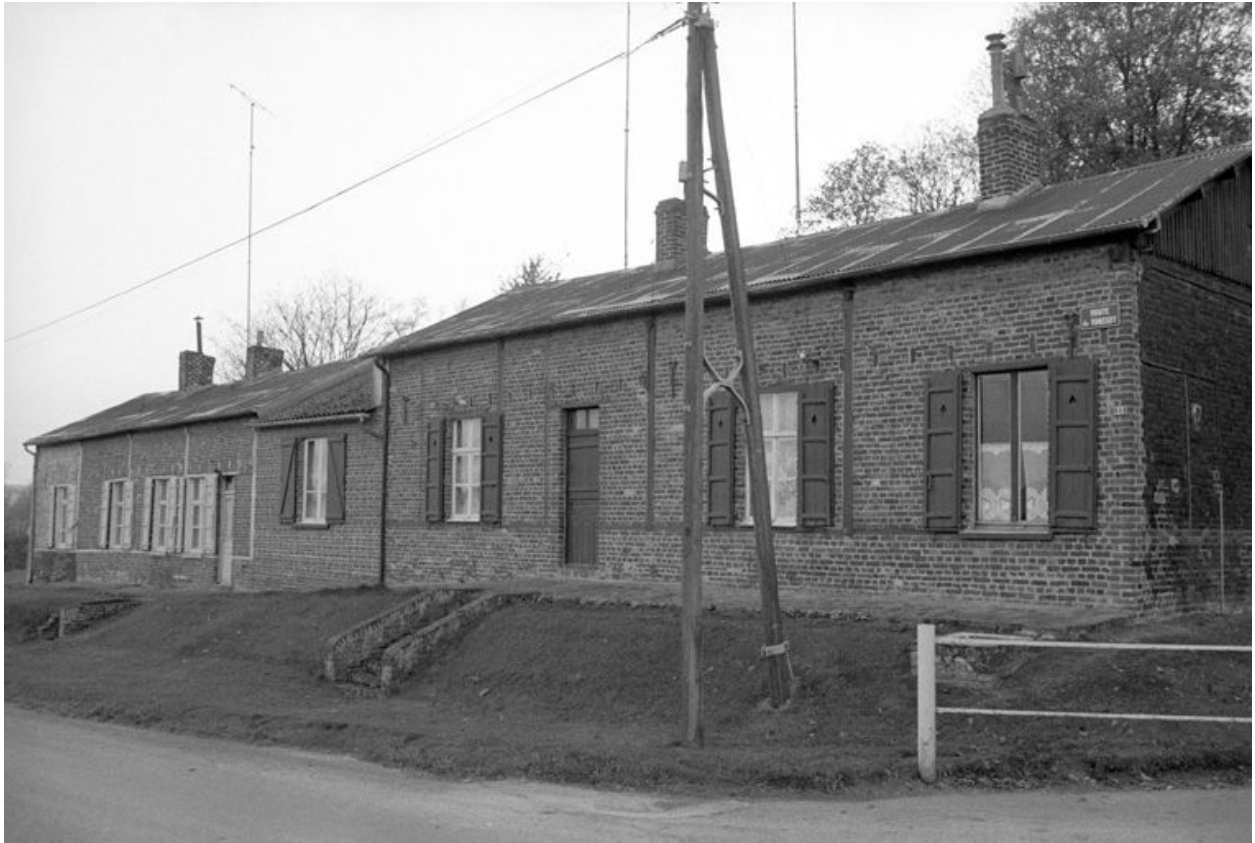
Logement d'ouvriers, vue générale.
