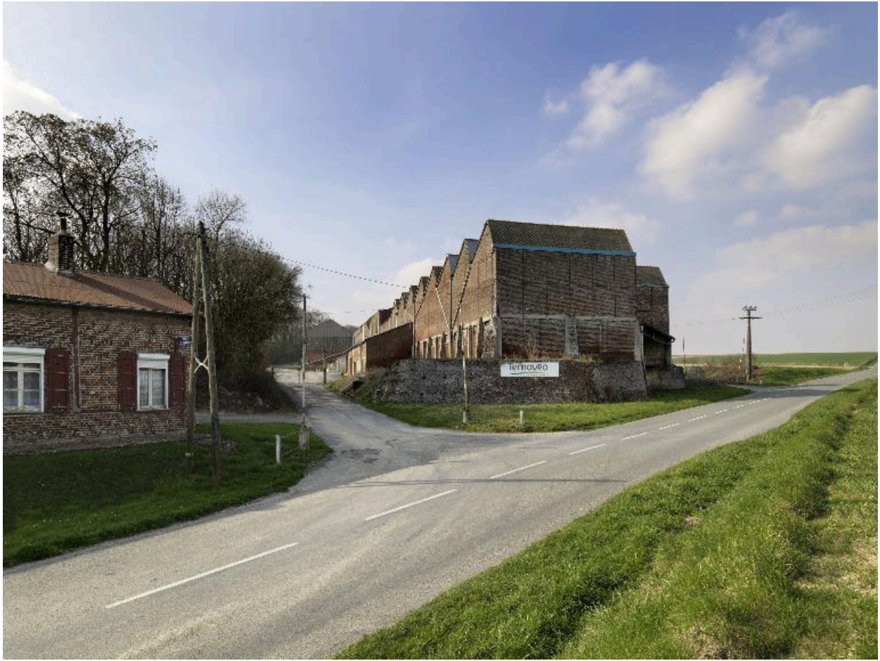
L'usine de phosphate depuis la route.
