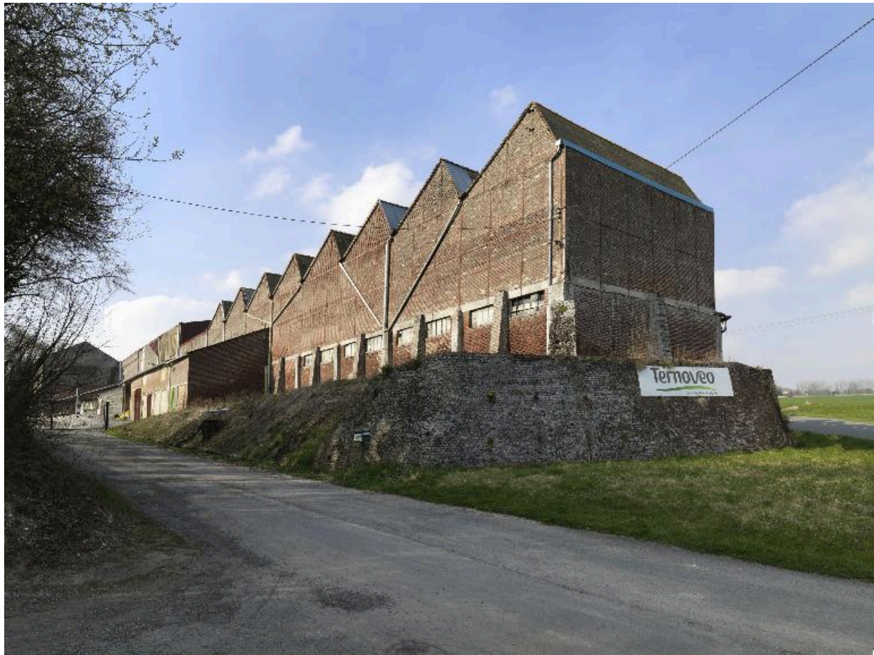
Atelier de traitement des phosphates.
