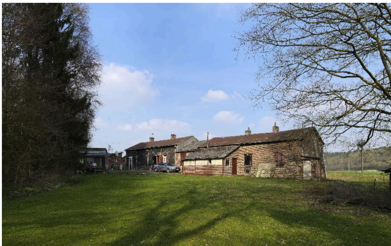
Les logements ouvriers dependants de l'usine.
