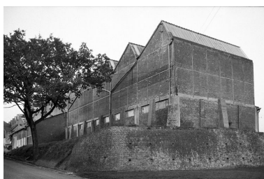
Vue partielle. Phot. Francis Dubuc IVR22_19908001364Z
