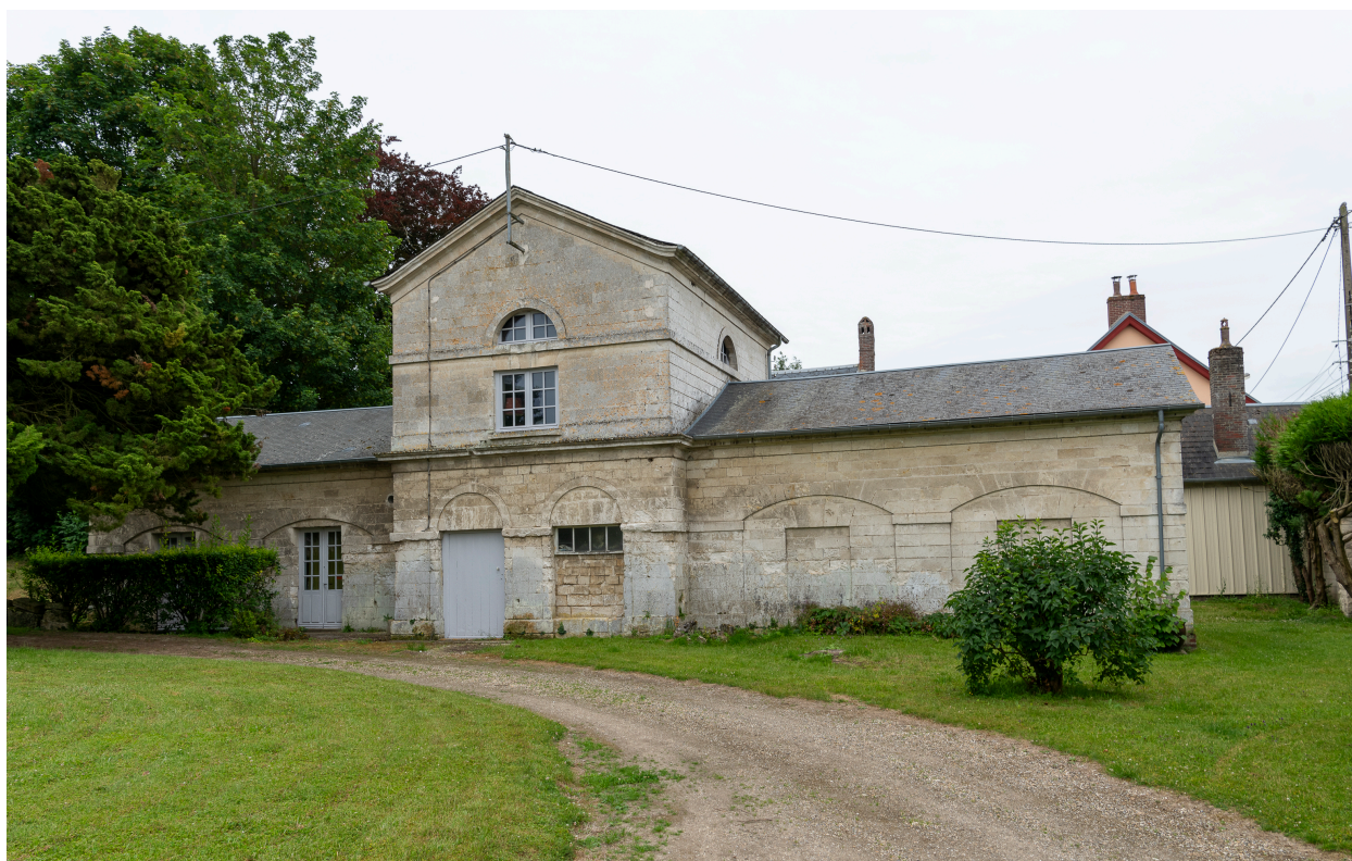
Dépendances côté sud, vue depuis le nord.
