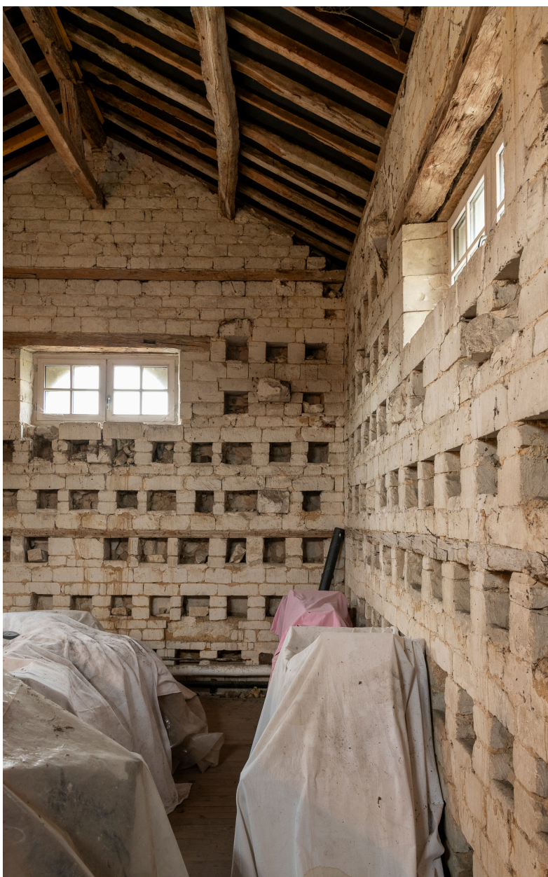
Intérieur du pigeonnier dans les dépendances côté nord.
