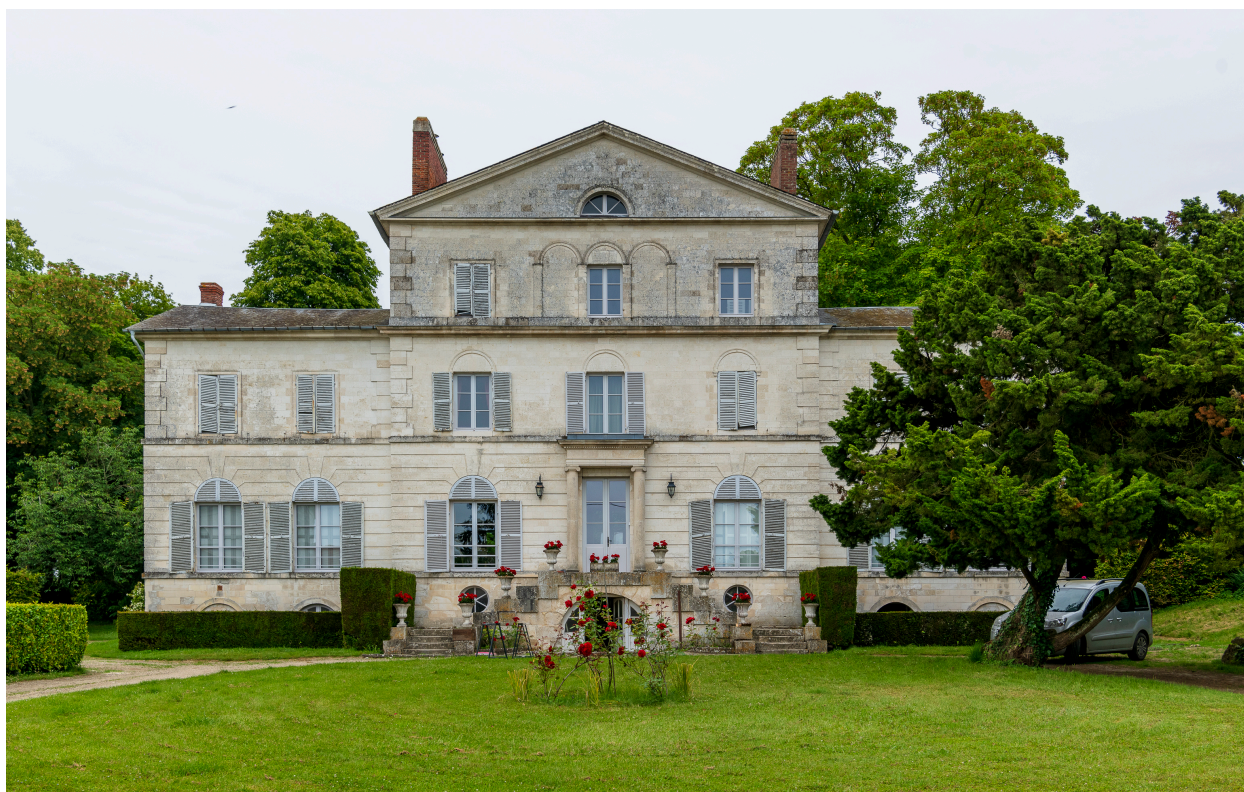
Façade de la demeure depuis la cour (ouest).
