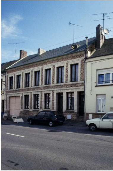
Vue de la façade sur rue. Phot. Frédéric Fournis IVR22_20030200165ZA
