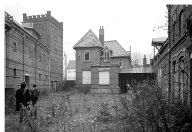
Vue de la cour prise vers le nord-est : à gauche le germoir et la touraille de la malterie, à droite les écuries.
