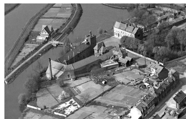
Vue aérienne oblique prise vers le nord de la brasserie, 1952 (IGN. Photothèque nationale. 1952). Repro. Jean-Marc Ramette IVR32_20235905027NUC
