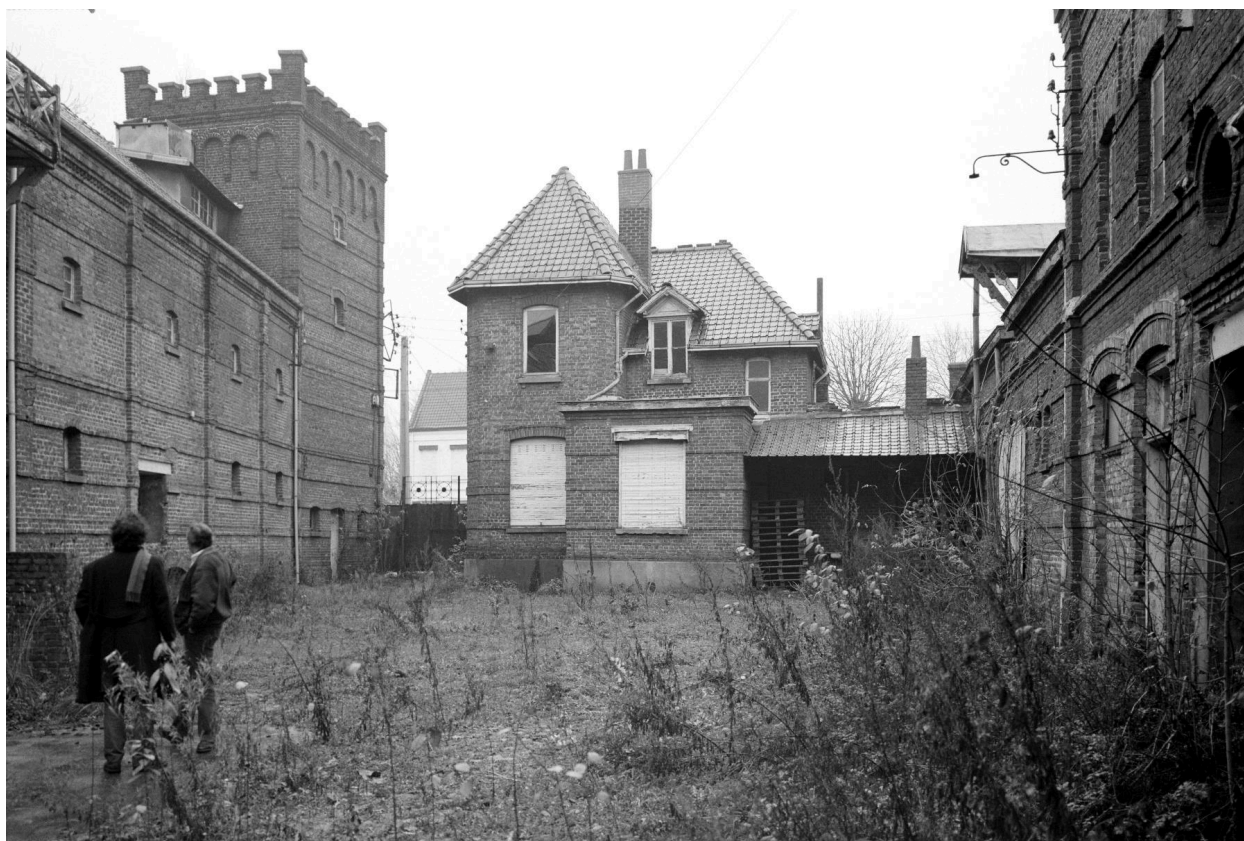
Vue de la cour prise vers le nord-est : à gauche le germoir et la touraille de la malterie, à droite les écuries.
