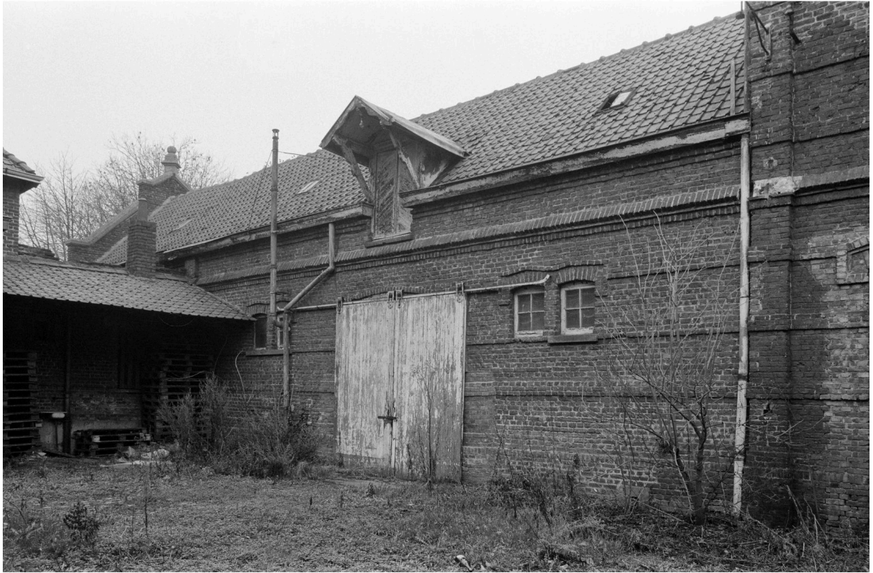
Écuries, élévation sur cour.
