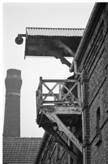
Monte-sacs de la malterie et cheminée. Phot. Olivier Marlard IVR31_19885902551Z
