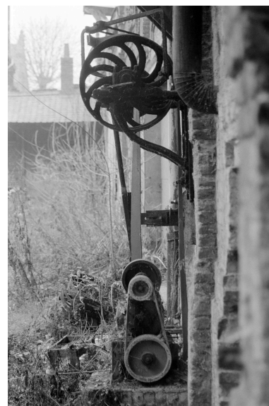
Pompe extérieure de la brasserie. Phot. Olivier Marlard IVR31_19885902545Z
