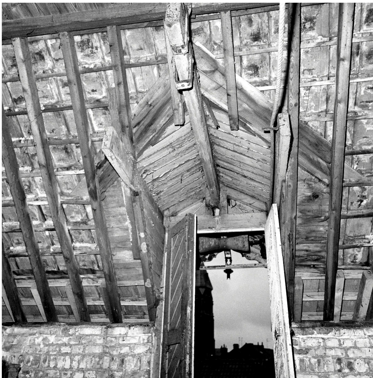
Lucarne passante et monte-sacs de la malterie. Vue intérieure.
