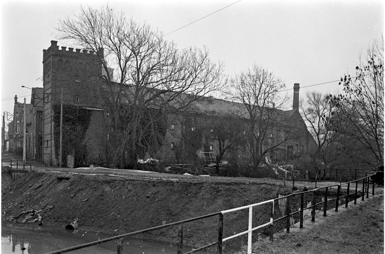
Vue générale prise vers le sud.
