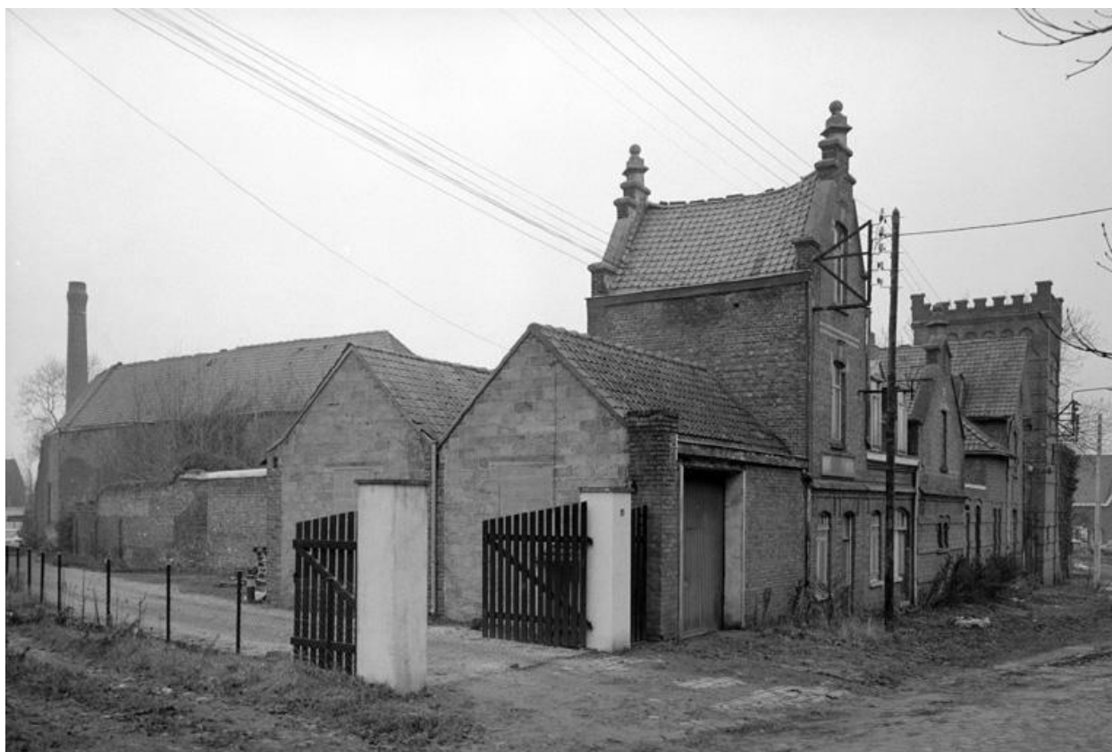
Vue générale vers le nord-ouest.
