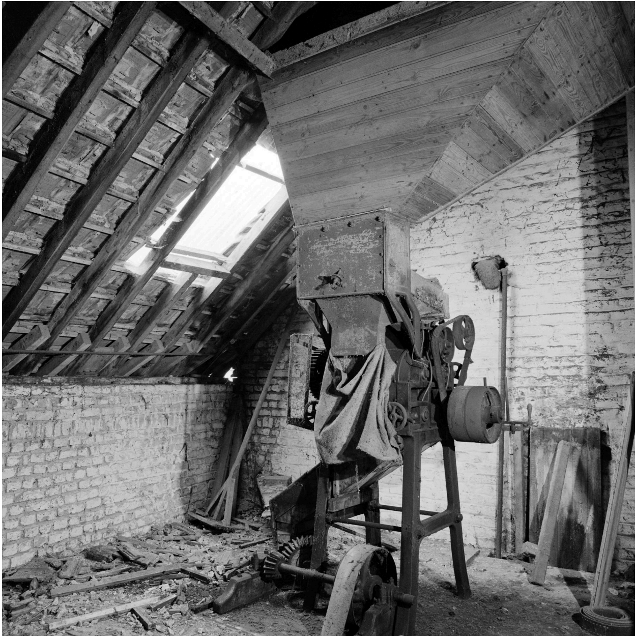
Combles de la malterie. Moulin à farine et ensacheur.
