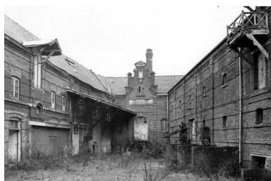
Vue générale de la cour vers le sud-est. A fond se situe la brasserie, à droite le germoir de la malterie et à gauche les écuries et le magasin à grains. Phot. Olivier Marlard IVR31_19885902264X
