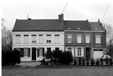
Logement patronal et logement du contremaître (?). Phot. Olivier Marlard IVR31_19885902301Z
