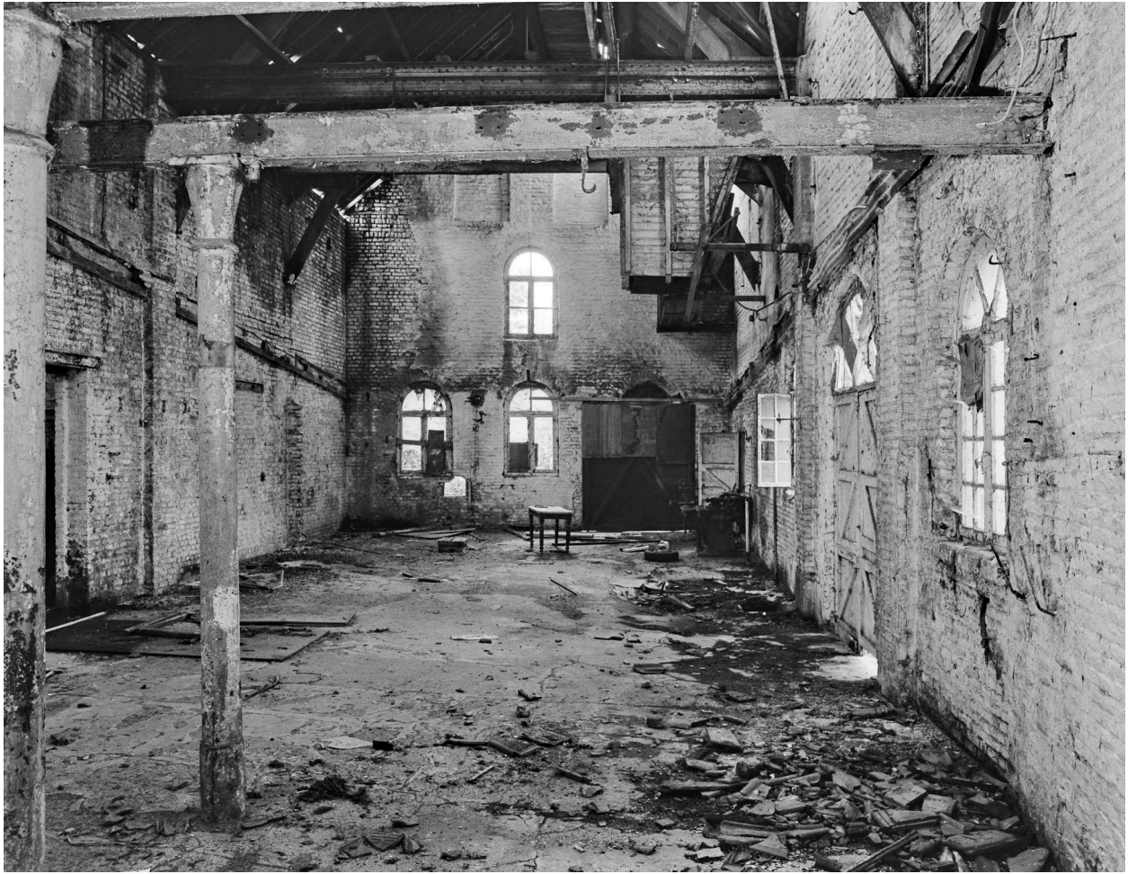
Vue longitudinale de l'intérieur de la brasserie.
